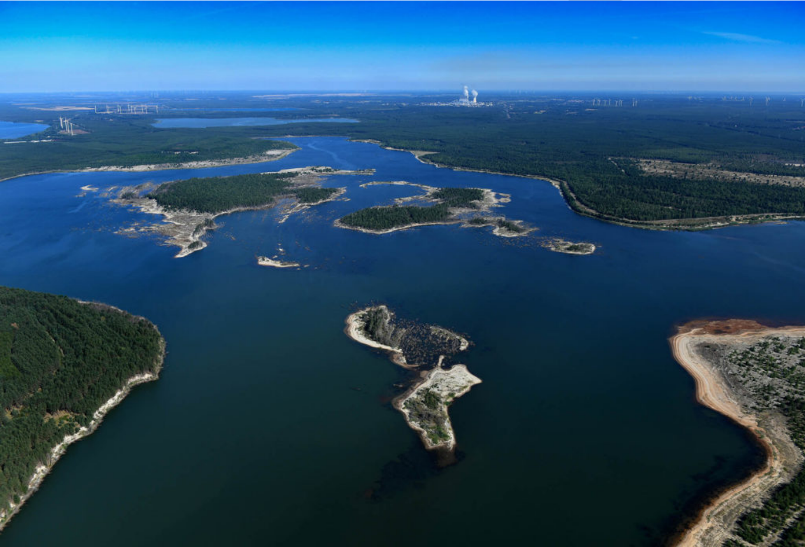
Blick über den bergbaulichen LMBV-Speicher Lohsa II 2020
