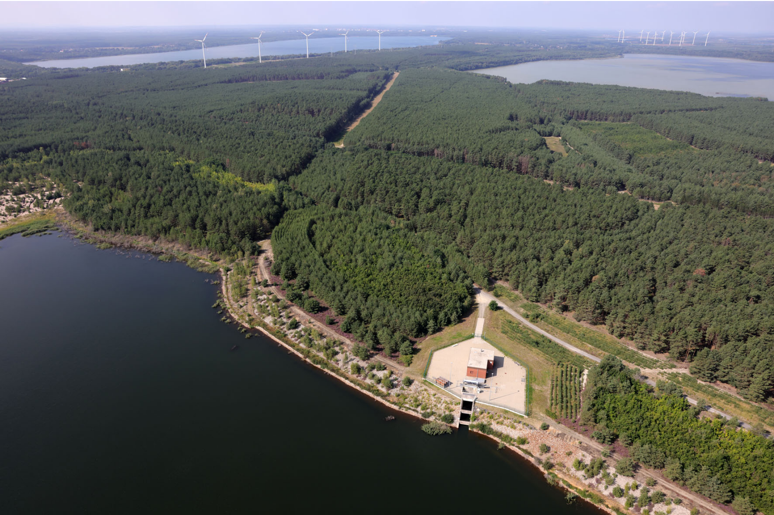
LMBV-Luftaufnahmen vom Speicher Lohsa II – Tunnel zum RL Burghammer
