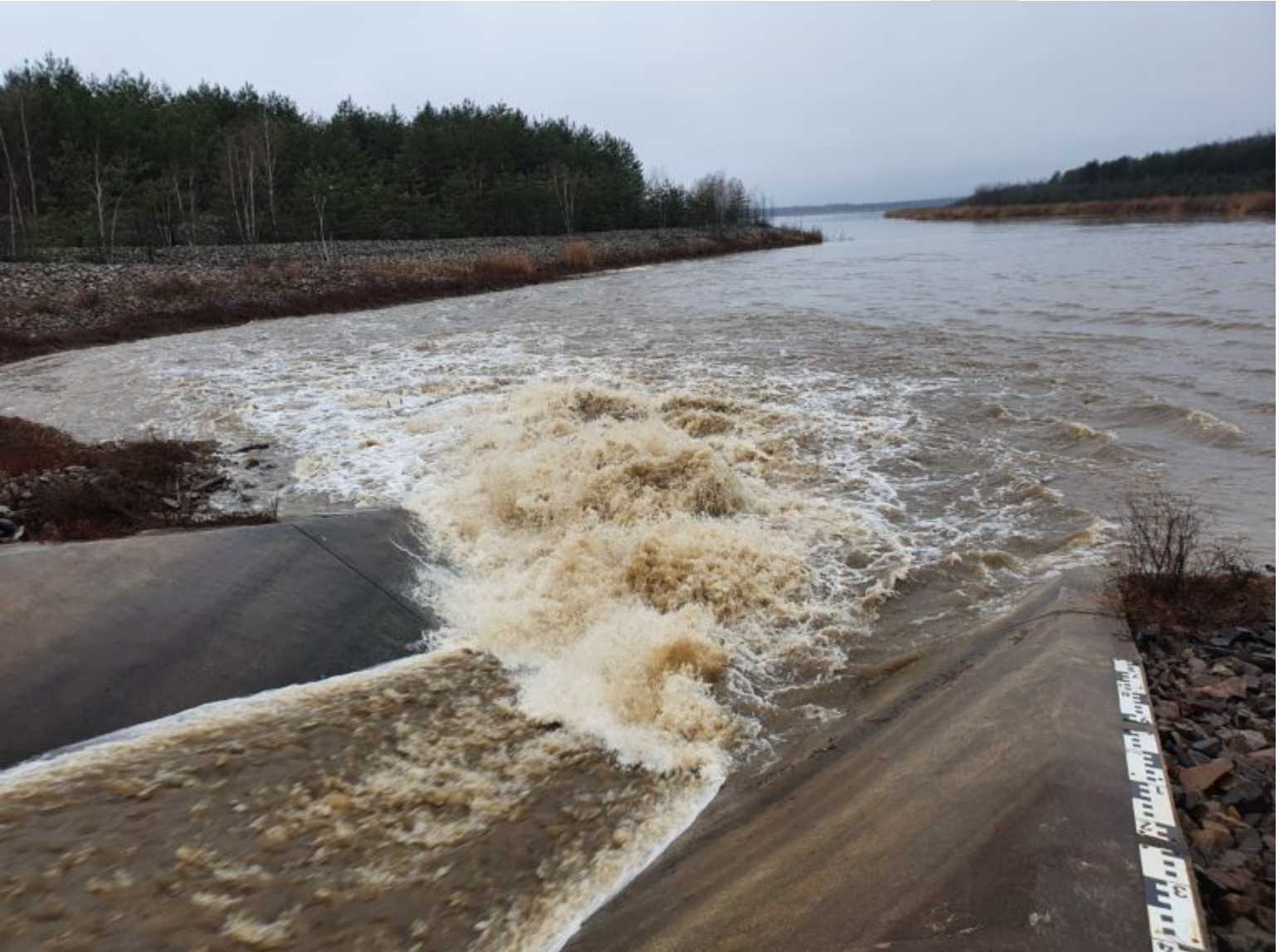
Absturzrampe ins Speicherbecken Lohsa II – Spreewasser schießt mit 6,2 m 3 /s ein
