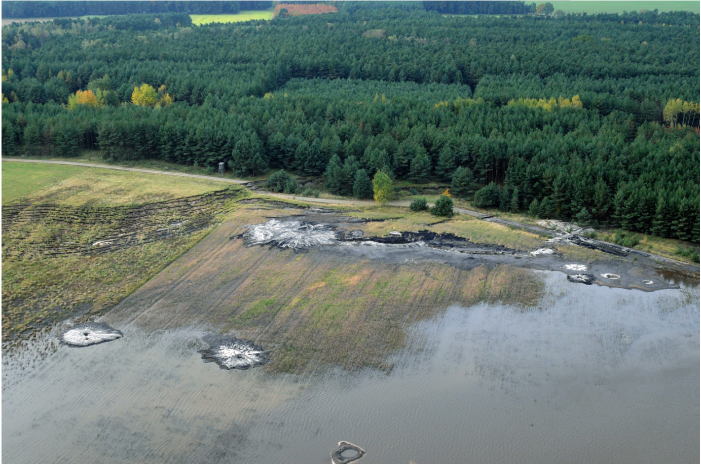
Grundbruch im Bereich Spreetal (2010)
