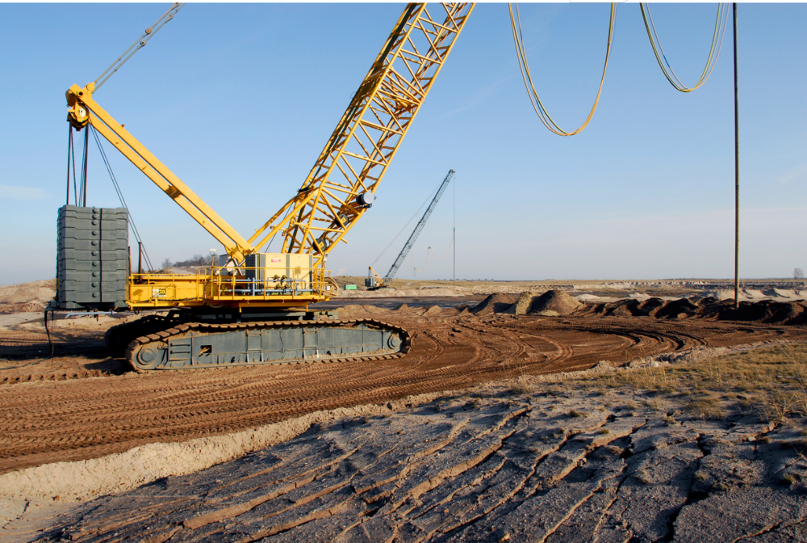
Einsatz von Rütteldruckverdichtung in der Lausitz (2012)
