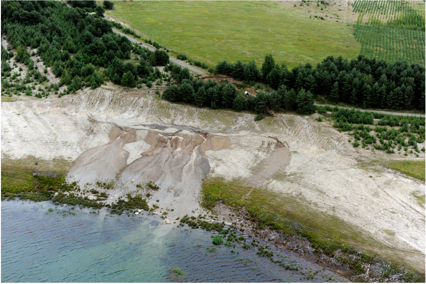
Rutschung am Speicherbecken Lohsa II (2012)
