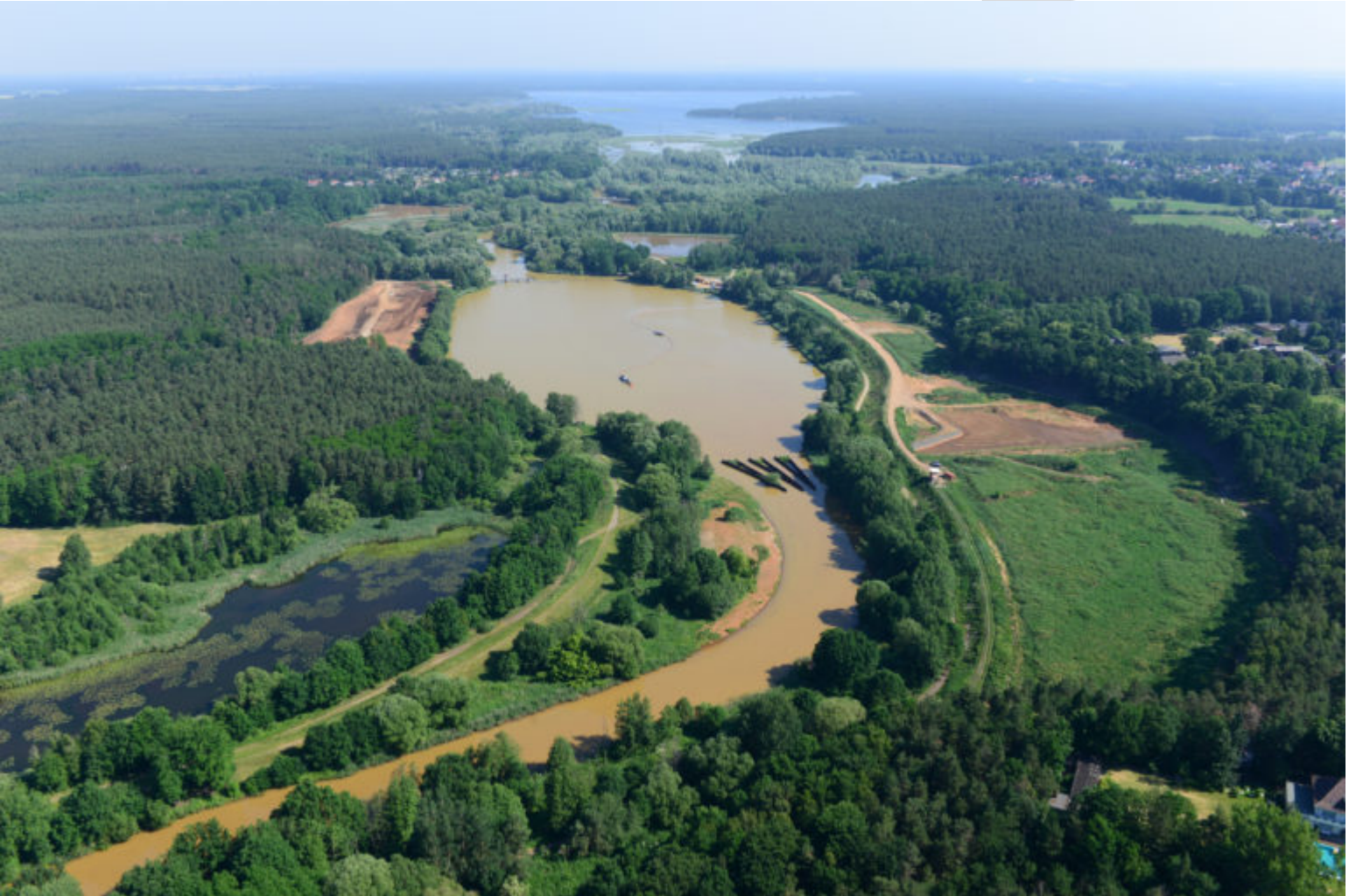
Blick auf die Vorsperre Bühlow mit der Talsperre Spremberg im Hintergrund
