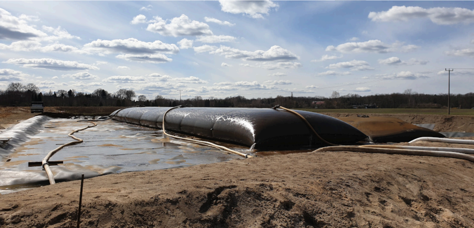
Aufnahmebehälter aus Geotextil für abgesaugten Schlamm aus Kleiner Spree Ausbau-Fotos aus 2020
