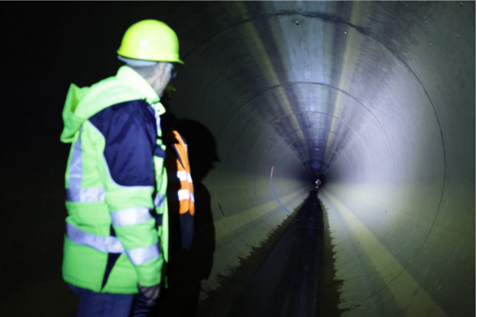
LMBV Überleiter Speicherbecken Lohsa II
