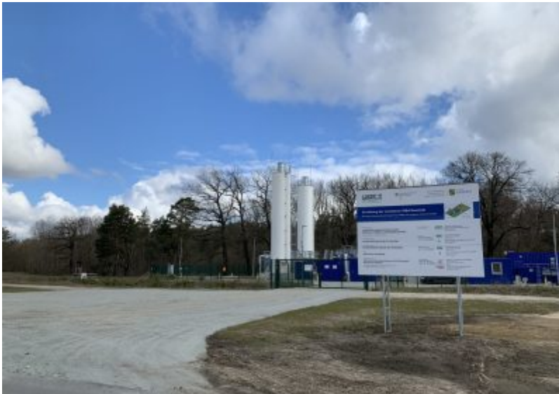
LMBV-Anlage bei Neustadt an der Spree
