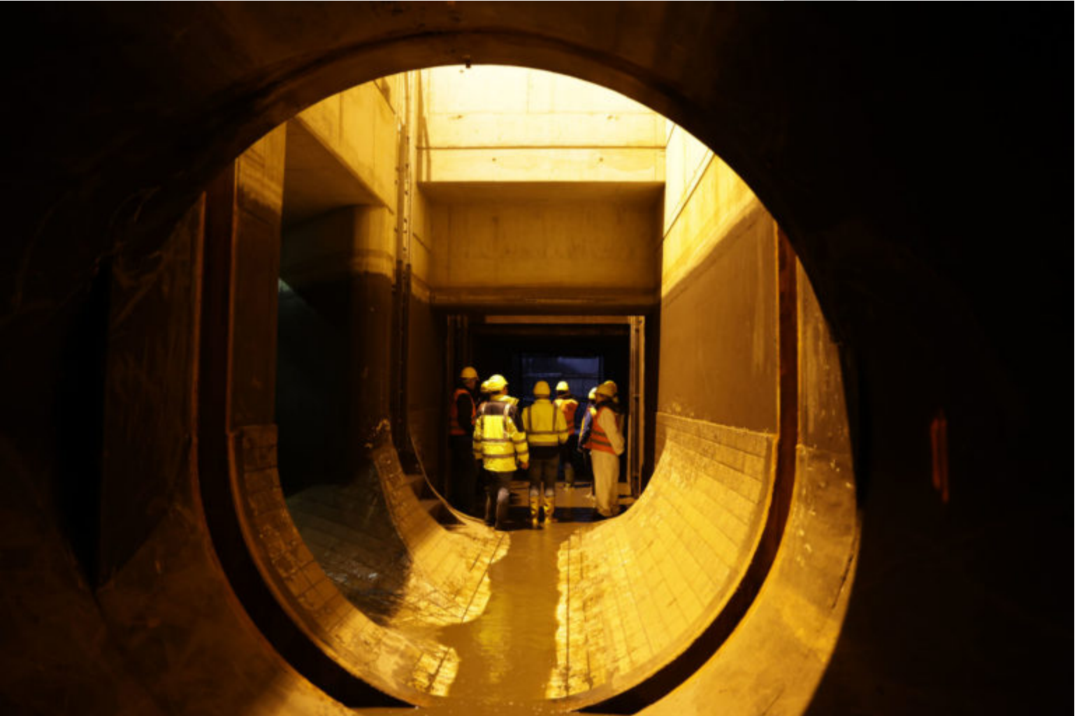
LMBV Überleiter Speicherbecken Lohsa II
