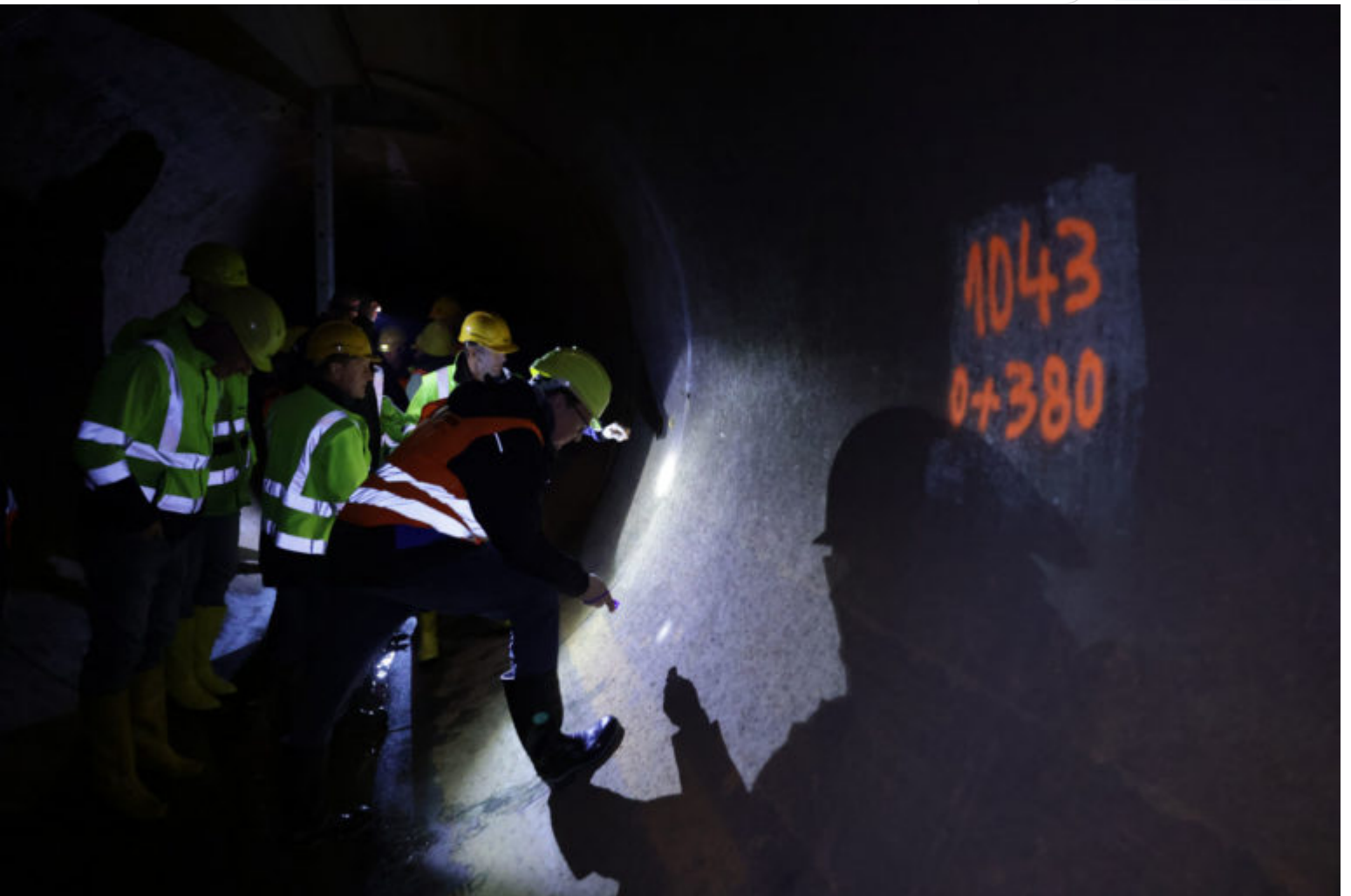
LMBV Überleiter Speicherbecken Lohsa II
