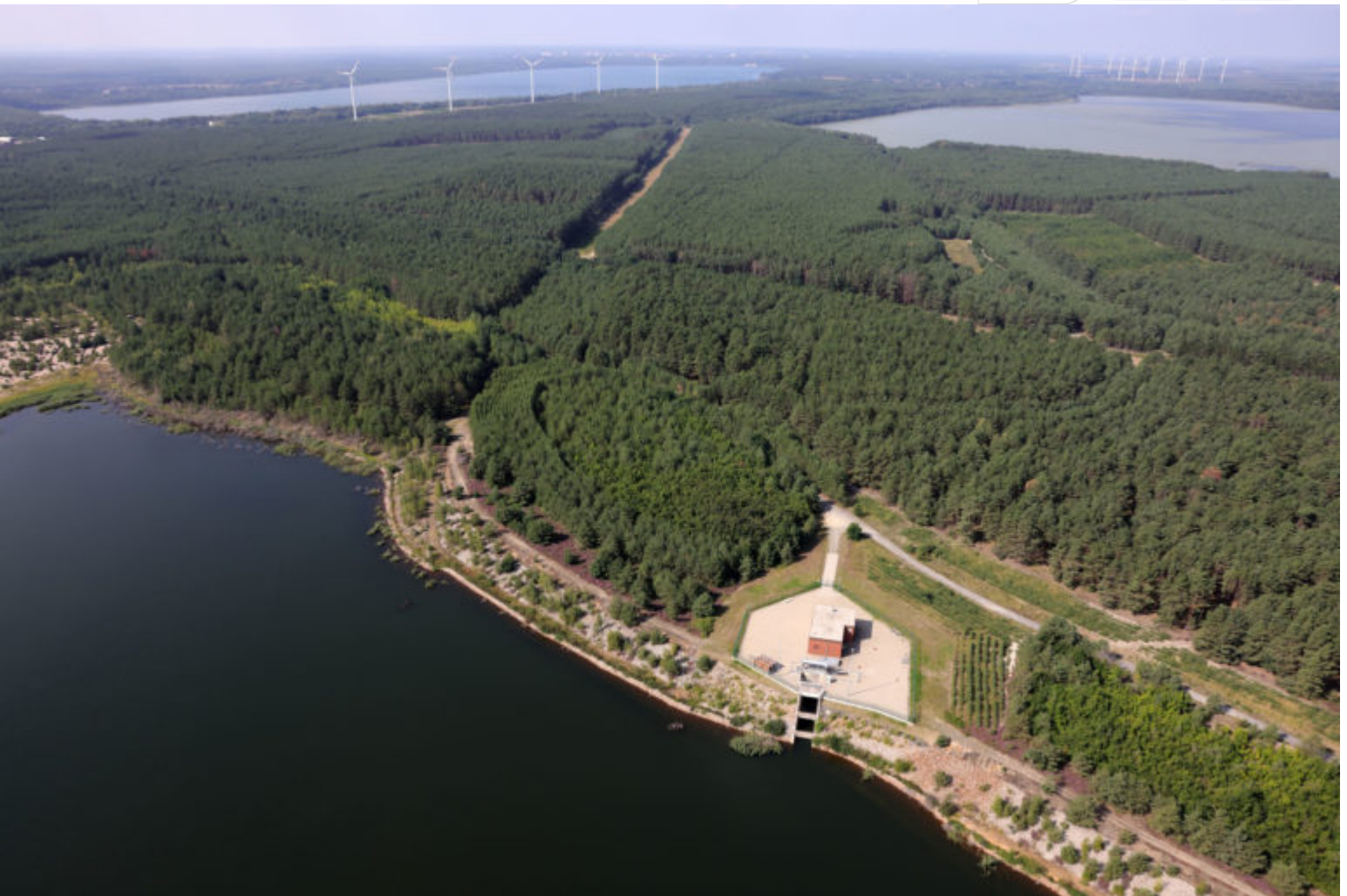
Einlaufbauwerk im SB Lohsa II
