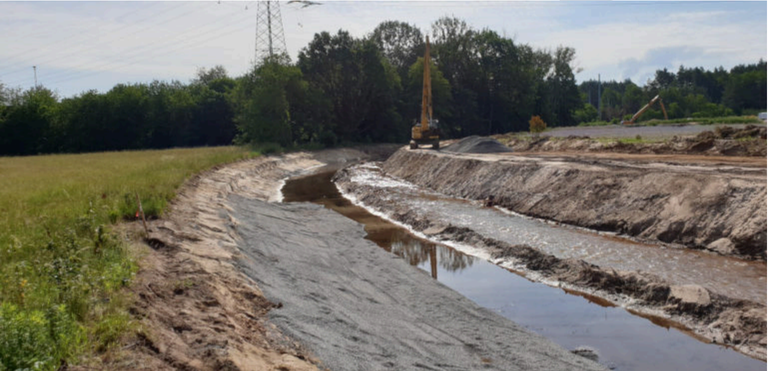
Arbeiten in der laufenden Welle der Kleinen Spree
