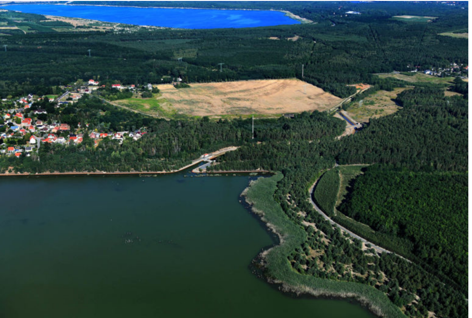
Auslaufbauwerk aus dem SB Burghammer
