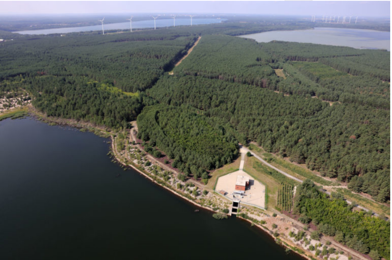
Einlaufbauwerk im SB Lohsa II
