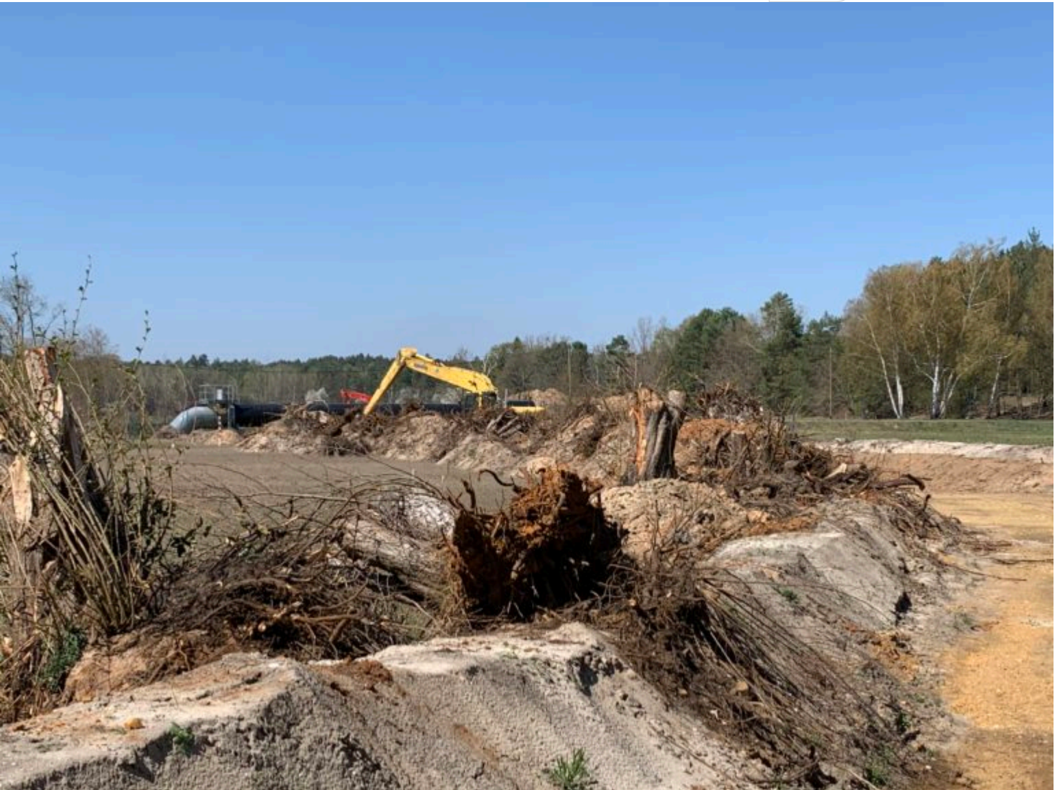
Abschnitt III zur Entschlammung der Kleinen Spree
