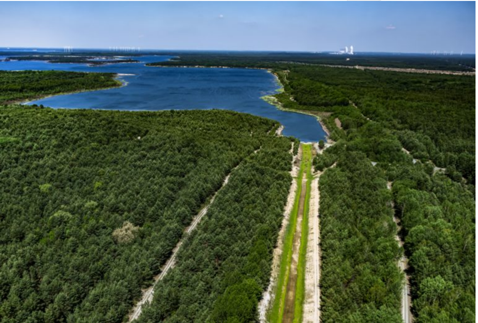
Zulauf-Anlage für den Speicher Lohsa II
