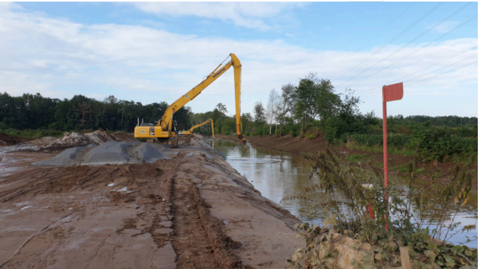
Einseitiger Ausbau der Kleinen Spree
