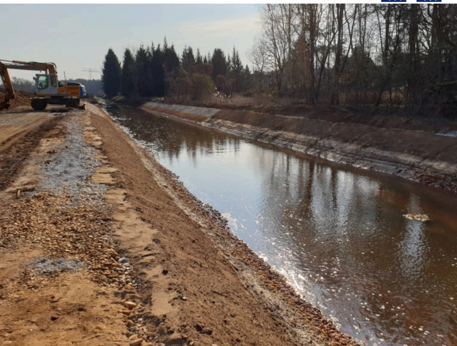
Uferausbau an der Kleinen Spree
