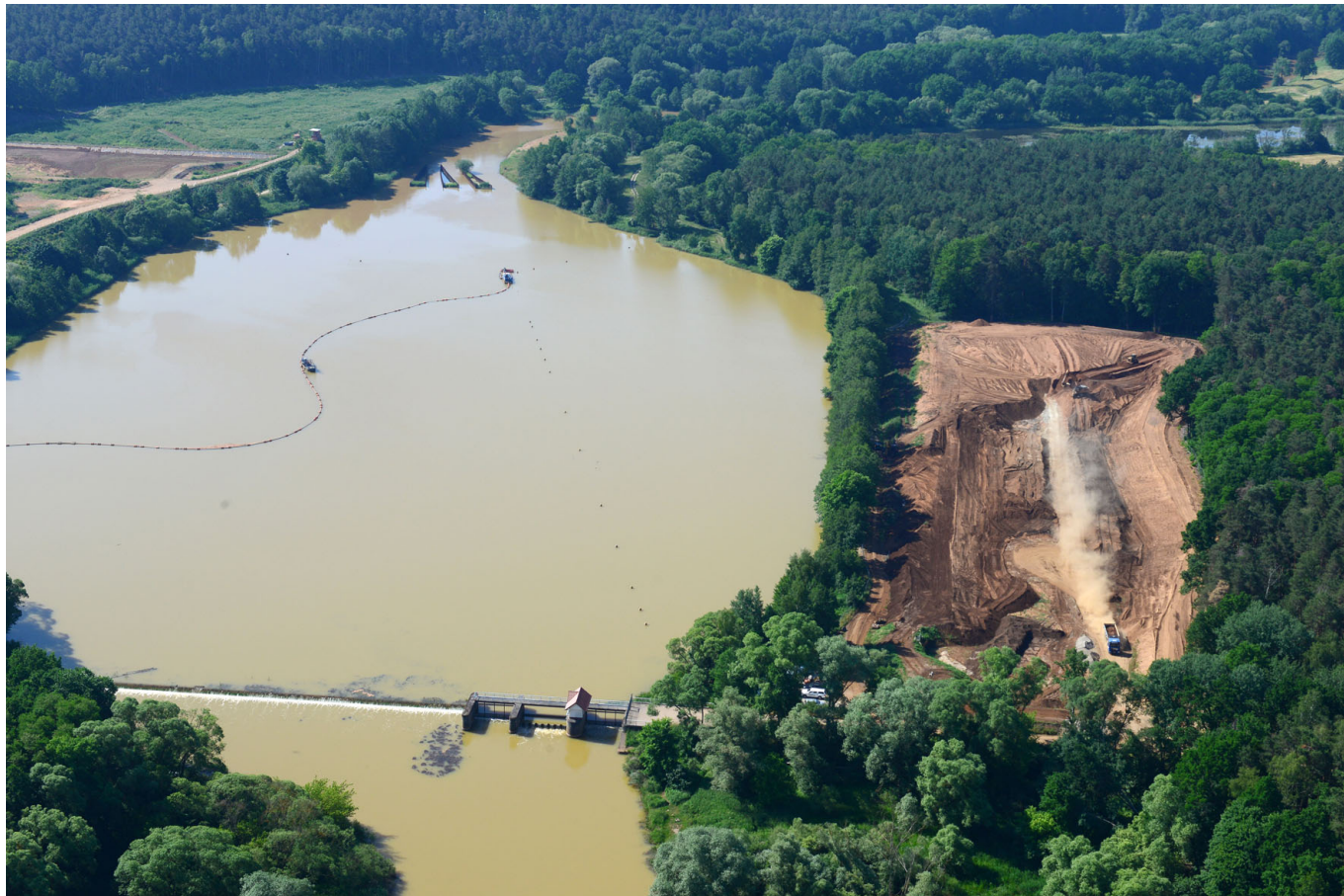
Sedimentationsbecken an der Vorsperre Buhlow
