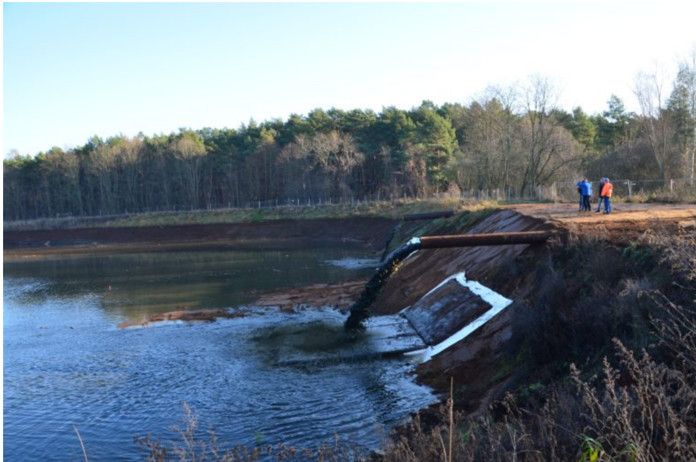
Sedimentationsbecken wird wieder befüllt
