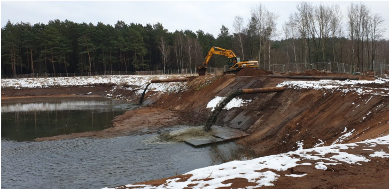
Das Einspülen in des Sedimentationsbecken begann am 25.01.2021
