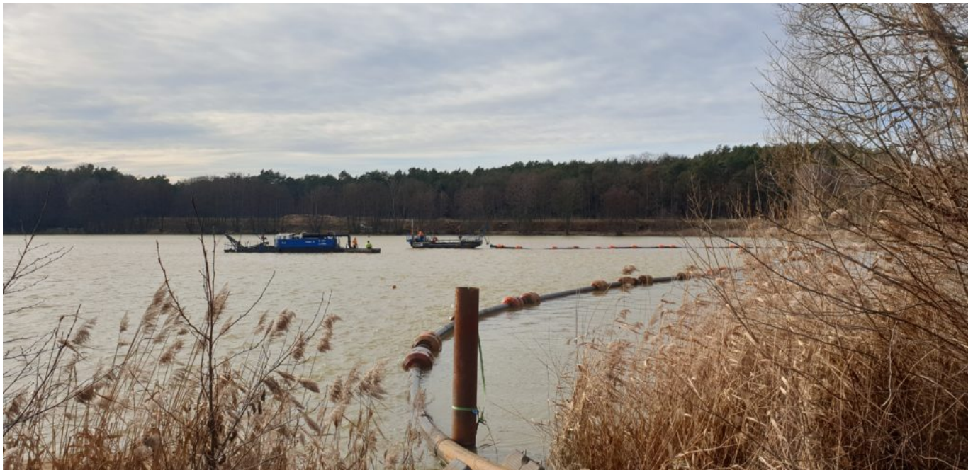
Saug-/Spülbagger auch 2021 auf der Vorsperre Bühlow im Einsatz
