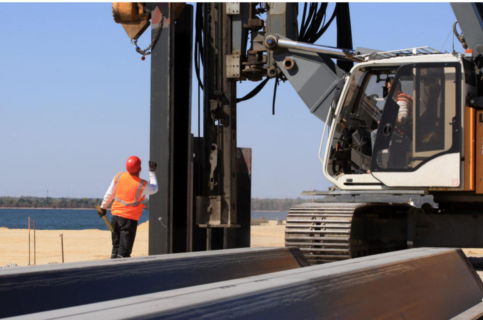
Sedlitzer Nordufer: Rammarbeiten für Kai an Einlassstelle und Sanierungsstützpunkt
