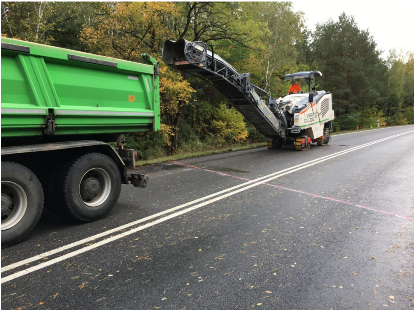
Asphaltfräsarbeiten auf dem gesperrten Abschnitt der B97
