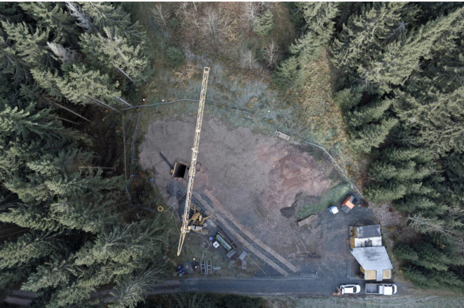
Blick auf die Baustelle mit Vorteufe, über welche der Tagesbruch mit Beton verfüllt wird
