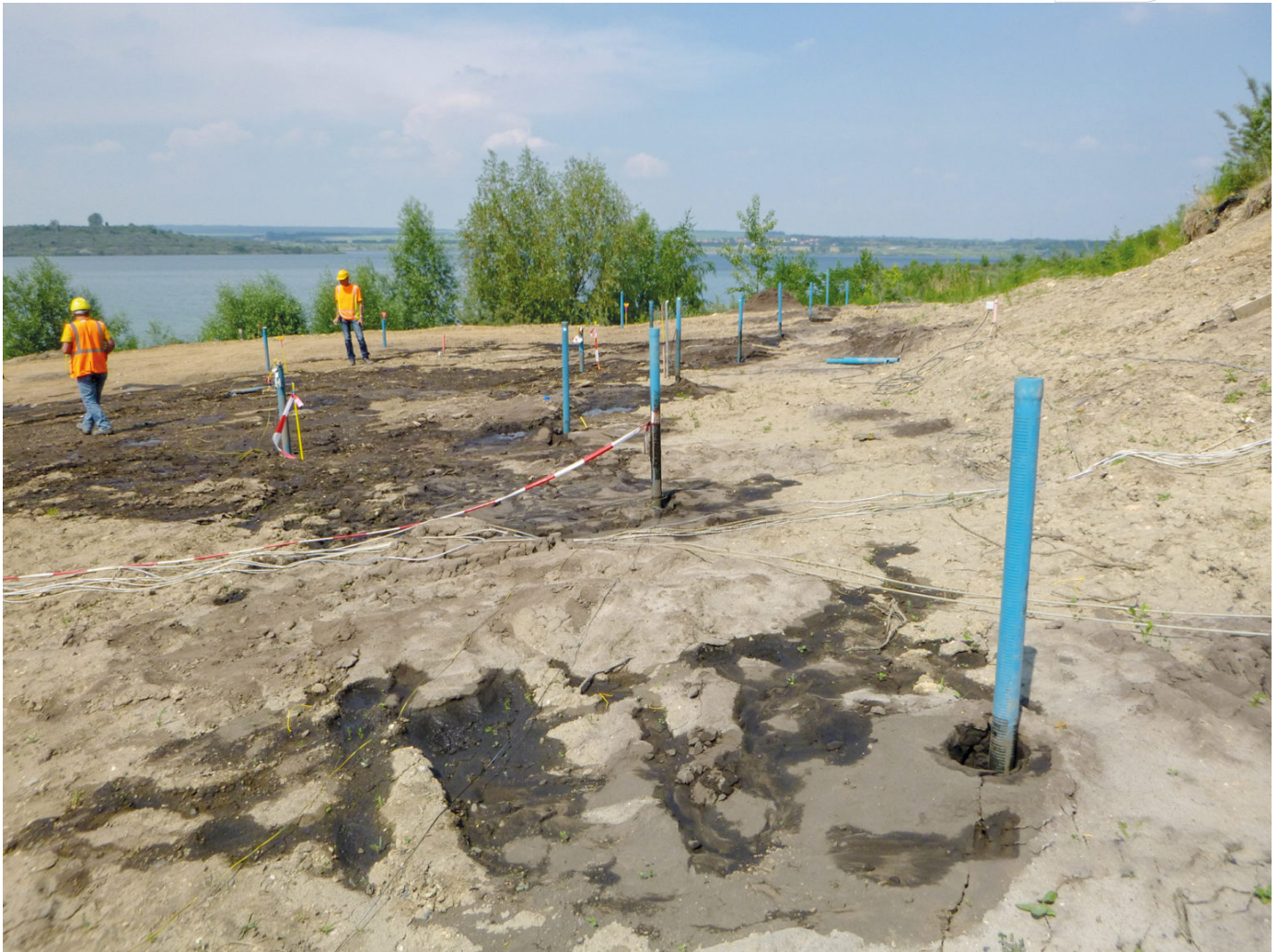
Sprengbohrlöcher für die Schonende Sprengverdichtung
