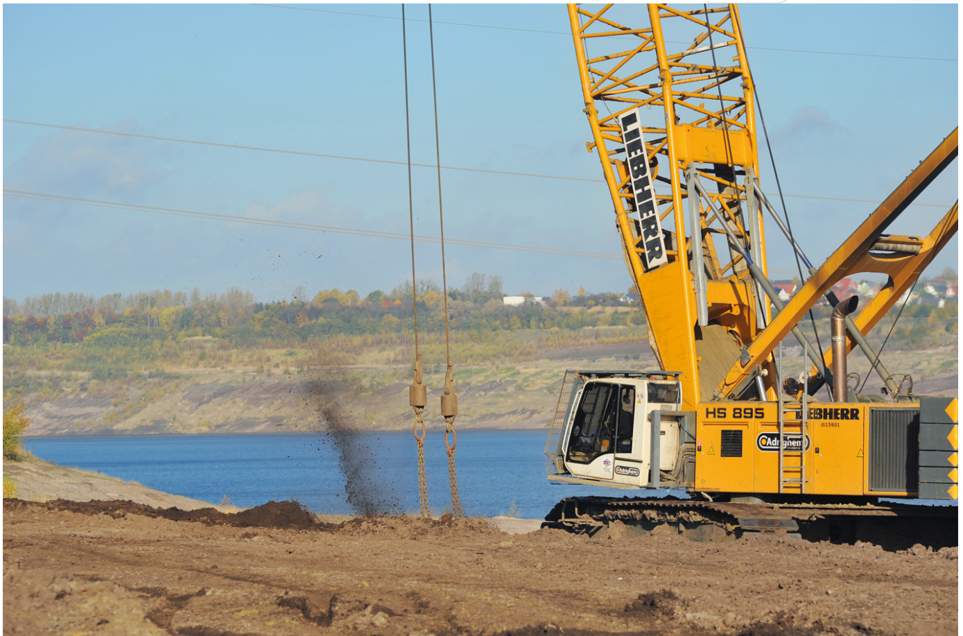
Fallplattenverdichtung im Tagebaurestloch Wulfersdorf
