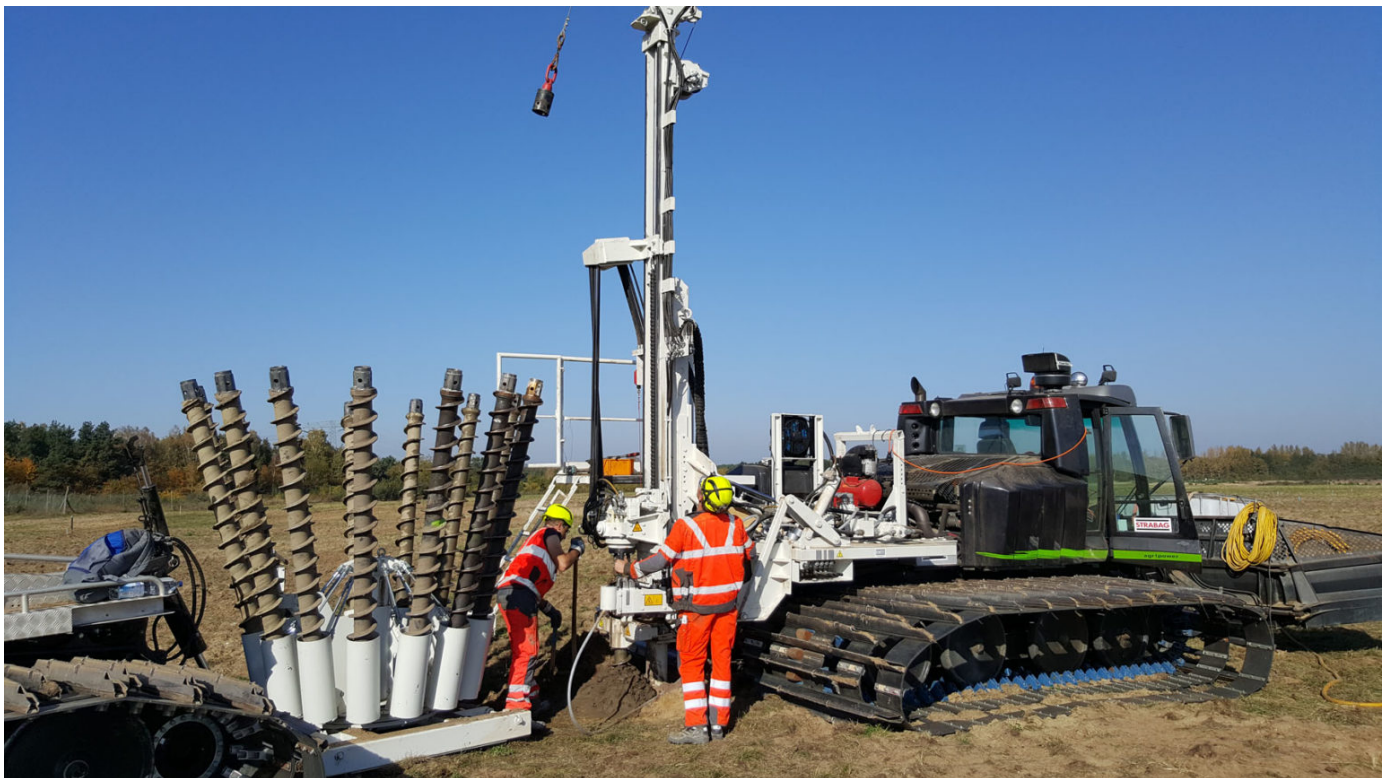
Bohren der Sprengbohrlöcher für die Schonende Sprengverdichtung
