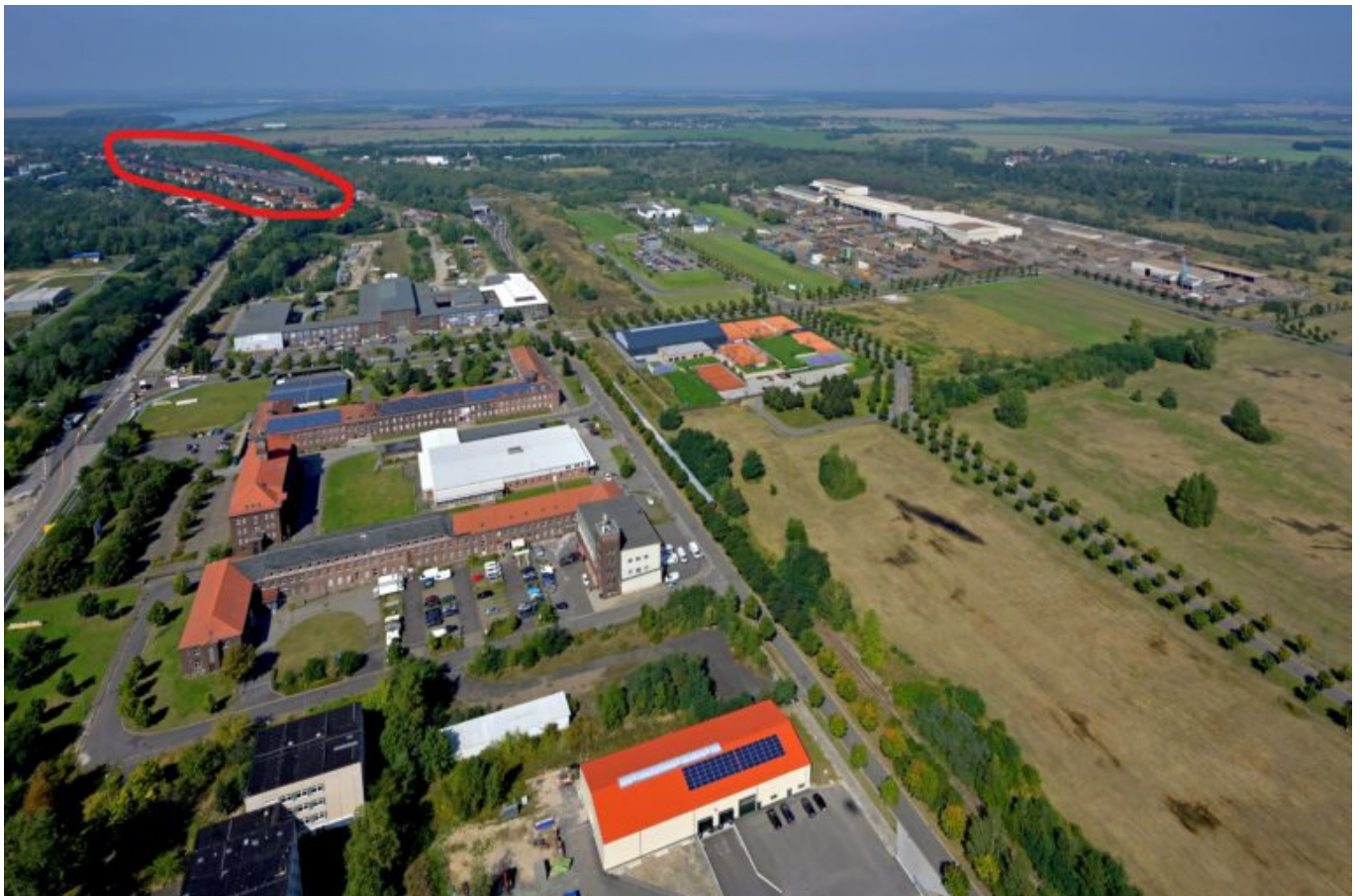
Verwahrung von Brauchwasserleitungen in Espenhain 3. Bauabschnitt, Foto: LMBV/Christian Bedeschinski
