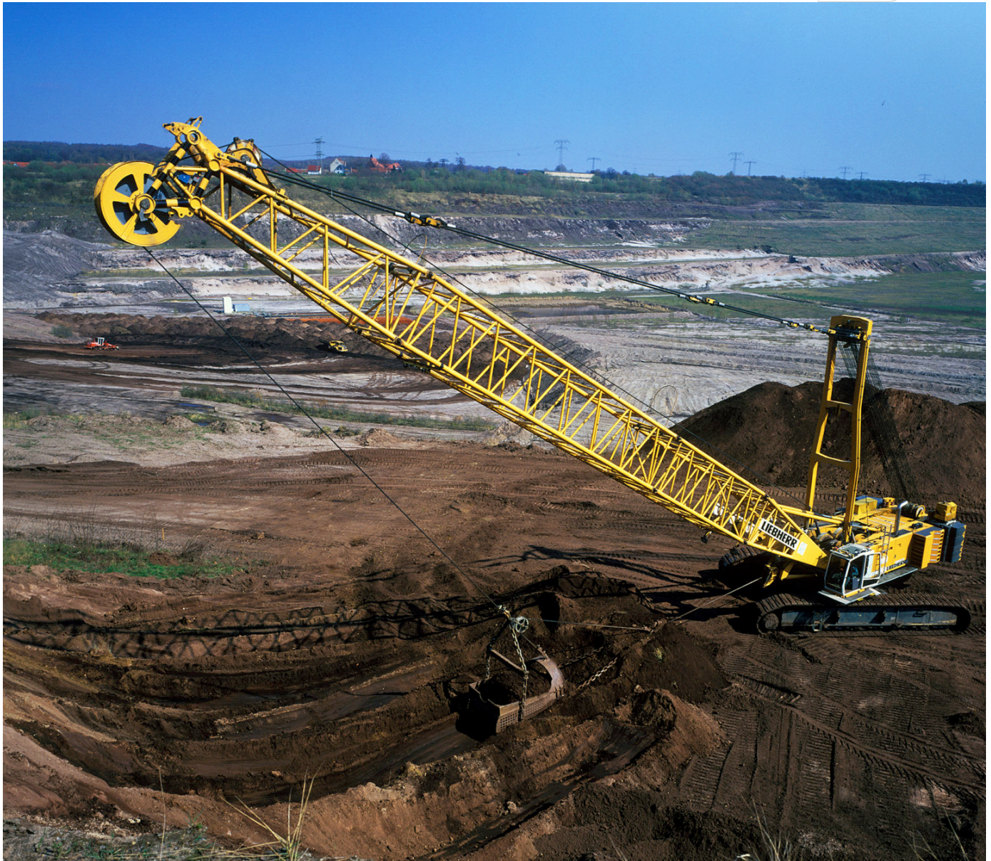
Sanierungsarbeiten im ehemaligen Tagebau Wulfersdorf
