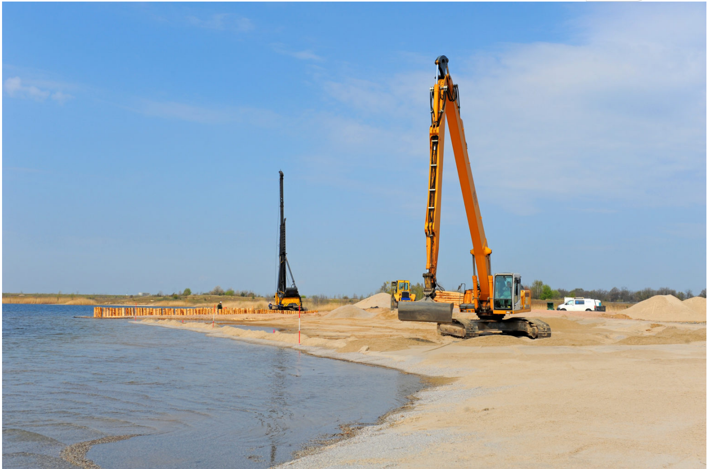
Ufersicherung am Restloch R ö sa
