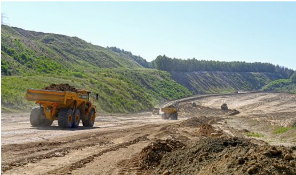
Anstützung der Südwestböschung der Kippe Wulfersdorf
