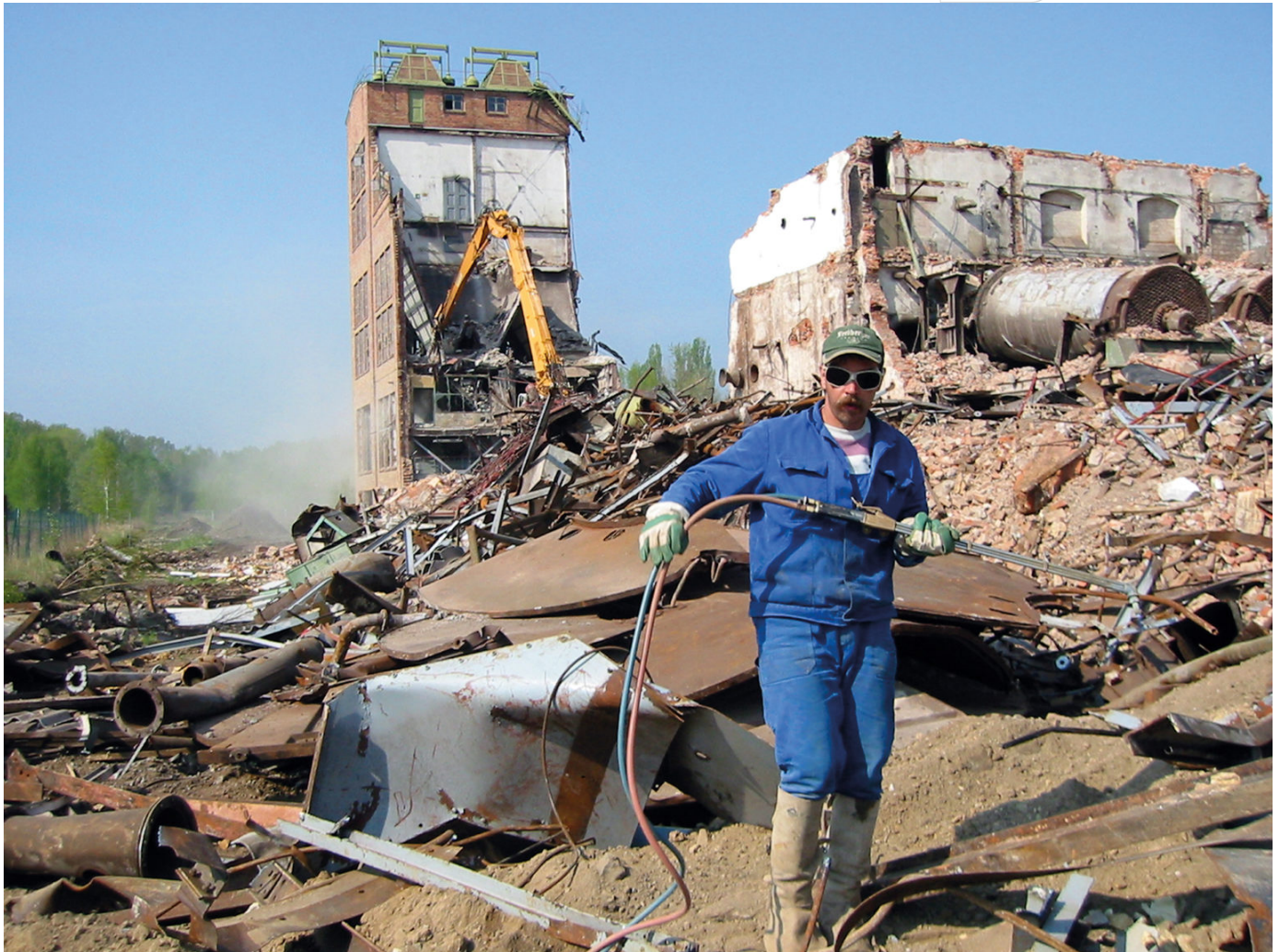
Abriss der Brikettfabrik Zechau (2004)
