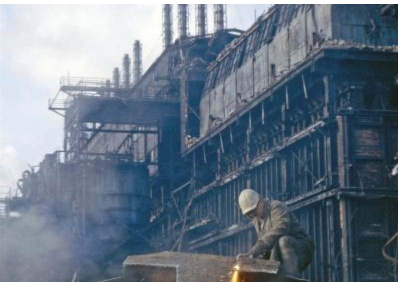
Abriss der Kokerei Lauchhammer (1993)
