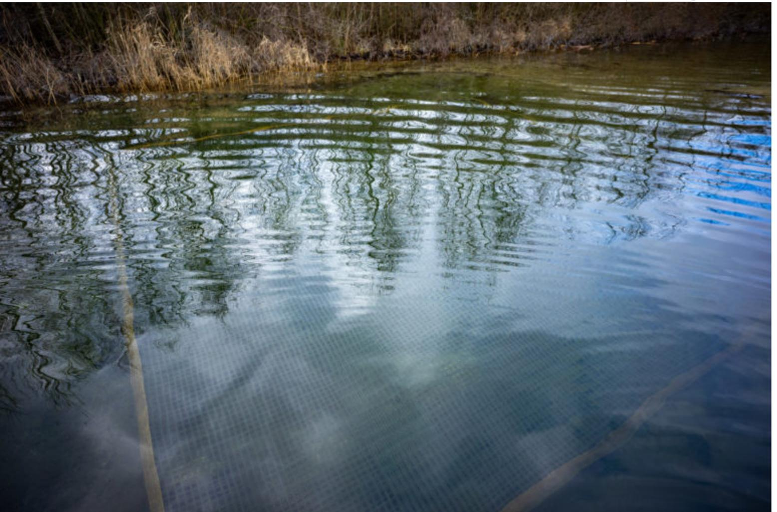
Das Geogitter wurde über dem Filterbrunnen platziert und wird anschließend mit Wasserbausteinen abgedeckt.
