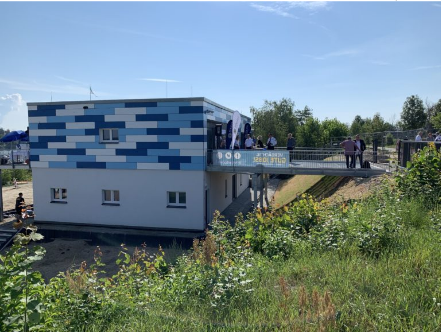
Die Polizeiwache im Gebäude des ZV LSS
