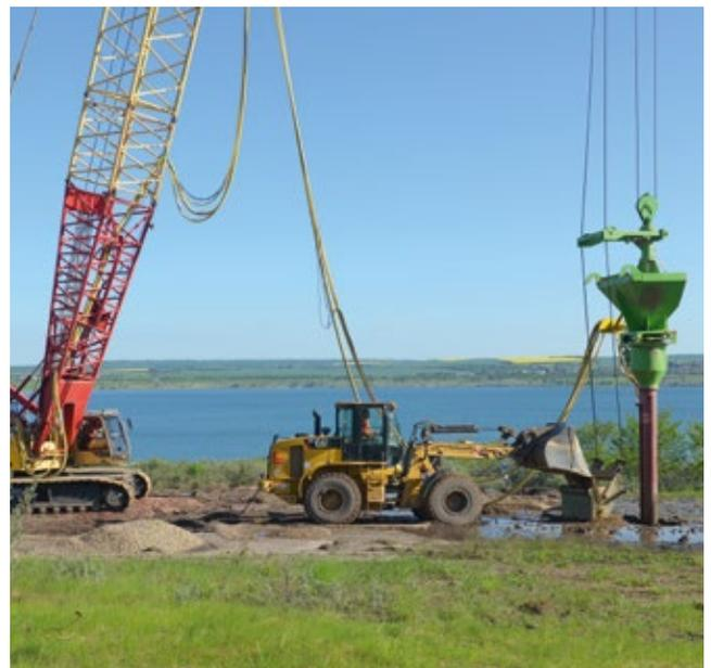
Verfahren zur Kippensicherung durch Rüttelstopfverdichtung.
