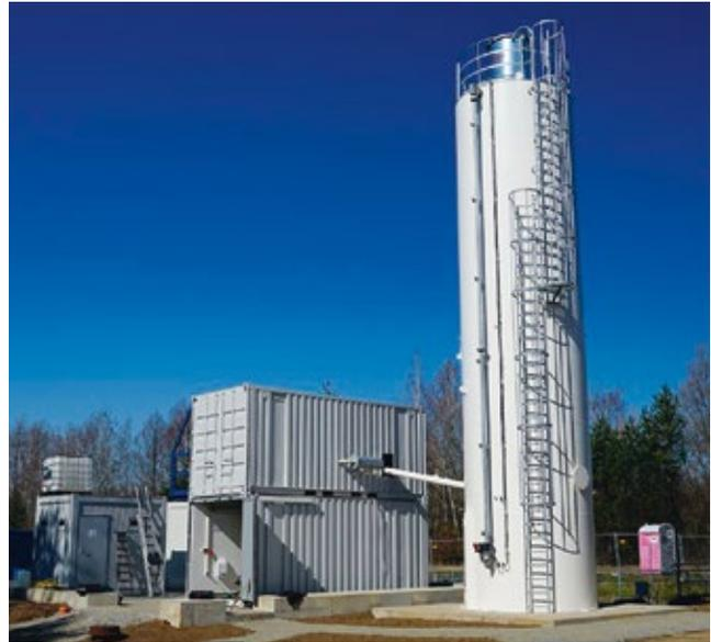
Im März 2015 erfolgte die Inbetriebnahme der Konditionierungsanlage an der GWRA Vetschau. Die mobile Anlage ermöglicht durch Wägung eine präzise Kalkmilchzubereitung, welche über ein Zulaufgerinne in die GWRA geleitet wird. Der Bedarf an Weißfeinkalk beträgt etwa 250 Kilogramm pro Tag.
