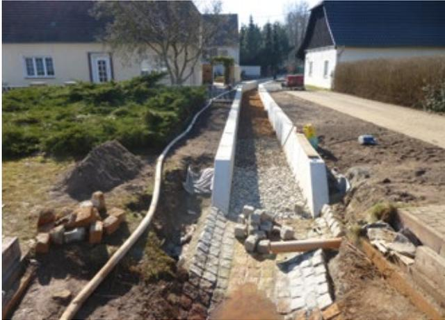
Zur Ableitung des verstärkten Grundwasserandranges wurde das Bornsdorfer Fließ im Bereich der Ortslage Bornsdorf ausgebaut. Hierzu wurden zwei Kanalabschnitte mit 45 und 75 Meter Länge aus Betonfertigteilen im Fließbett hergestellt. Östlich der Ortslage Bornsdorf erfolgte die hydraulische Ertüchtigung des Kohlegrabens auf einer Länge von 1.655 Metern.
