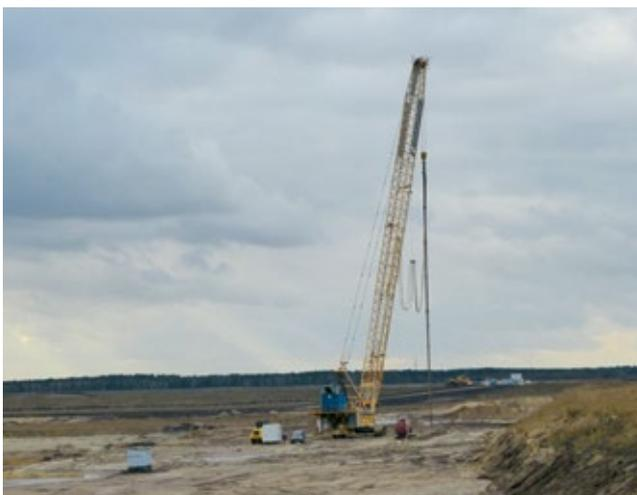
Im August 2015 begannen im bergrechtlichen Verantwortungsbereich der LMBV die RDV-Arbeiten an der Südostböschung zur standsicheren Gestaltung der zukünftigen Uferböschung des Cottbuser Ostsees. Mittels Rütteldruckverdichtung werden „versteckte“ Dämme mit insgesamt circa 125 Meter Breite und einer Länge von circa 1.200 Meter hergestellt.
