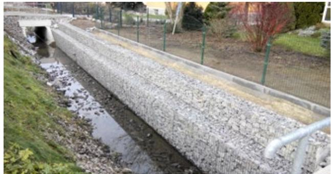
An der Landstraße L 49 in Lübbenau wurde der Straßenbegleitgraben auf einer Länge von 525 Metern renaturiert und für 11 Grundstückszufahrten die Durchlässe/Überfahrten erneuert. Die Arbeiten wurden im Dezember 2015 abgeschlossen.
