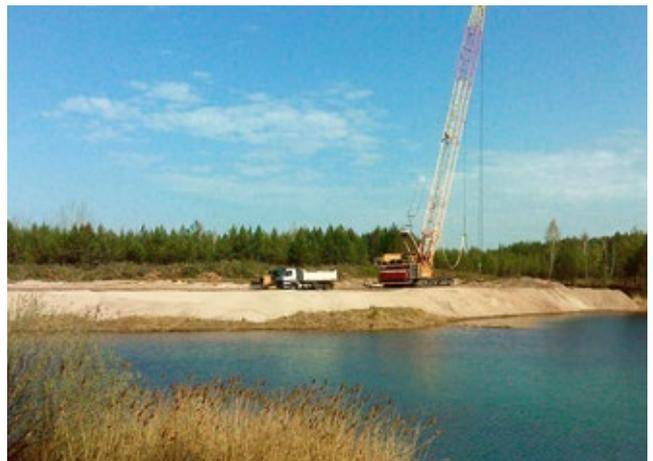
Im Oktober 2015 wurden die Maßnahmen zur Sicherung der Restlöcher 13-15 in Hosena abgeschlossen. Die Sicherung erfolgte durch Abflachung steiler Böschungsabschnitte, die Holzung von rund 4,3 Hektar, die Verdichtung von 294.000 Kubikmeter mittels Rütteldruckverdichtung und dem verbundenen Masseneinbau in einer Größenordnung von 33.000 Kubikmetern.
