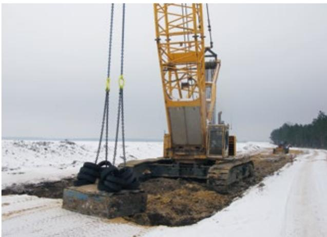
Mitte Oktober 2015 begannen die vorbereitenden Arbeiten für die geotechnische Sicherung des Hauptwirtschaftsweges zwischen der Ortslage Sedlitz und dem Tagebaurestloch. Die Sanierung der insgesamt 960 Meter langen Wegeverbindung erfolgte hauptsächlich mittels Fallgewichtsverdichtung. Die Anschlussbereiche zu den vorhandenen Wirtschaftswegen werden auf 35 Meter im Westen bzw. 31 Meter im Osten ausschließlich erdbautechnisch gesichert.
