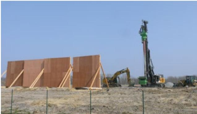
Im Tagebaubereich Lauchhammer wurden im III. Quartal 2015 die Arbeiten des 3. Bauabschnitts zur Sanierung des Restloches 40 mittels Rüttelstopfverdichtung (RSV) und mobiler Erdbau-technik abgeschlossen. Im Bereich der Finsterwalder Straße erfolgte der Anschluss des Grabens 1 an den Retentionsraum mittels RSV. Die RSV erstreckte sich auf einer Länge von 300 Meter und einer Breite von 29 Meter.
