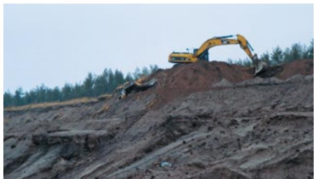
Seit Oktober 2015 setzte sich die bodenmechanische Sicherung des Kippenareals an der Ost- und Westböschung des Restloches 131-Süd fort. Im Bearbeitungsbereich Ost- und Westböschung des Restloches 131-Süd waren Wegebauarbeiten, Massenbewegungen mittels mobiler Erdbautechnik durch Masenauf- und abtrag sowie Massentransporte durchzuführen.
