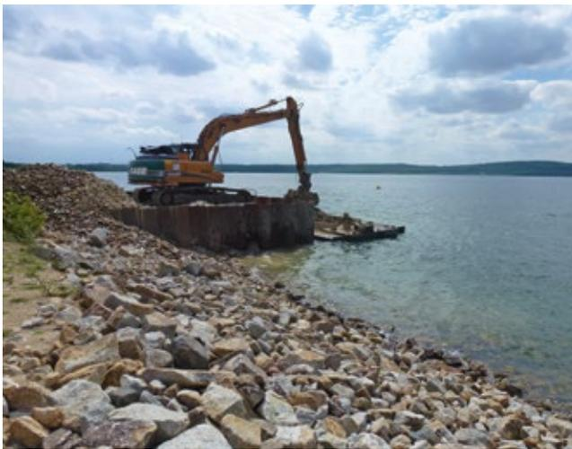
Zur Vermeidung von Sedimentablagerungen in der Auslaufrinne am Nordostufer des Berzdorfer Sees wurden beidseitig des Auslaufbauwerkes Steinschüttdämme hergestellt. Die Kronenbreite beträgt je 3,50 Meter und die Tiefe je circa 4,50 Meter. Der südöstliche Damm hat eine Länge von 80 Meter und der nordwestliche Damm eine Länge von 60 Meter.
