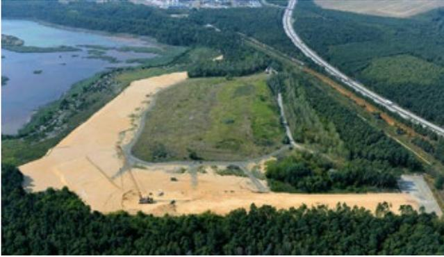
Zur Herstellung der geotechnischen Sicherheit von Tieflagen im ungesicherten Innenkippenbereich nördlich des Kabelbaggerteichs bestand das Erfordernis zur Auffüllung und Verdichtung dieser Flächen. Die Arbeiten begannen im Juli 2014 und wurden im November 2015 fertiggestellt.
