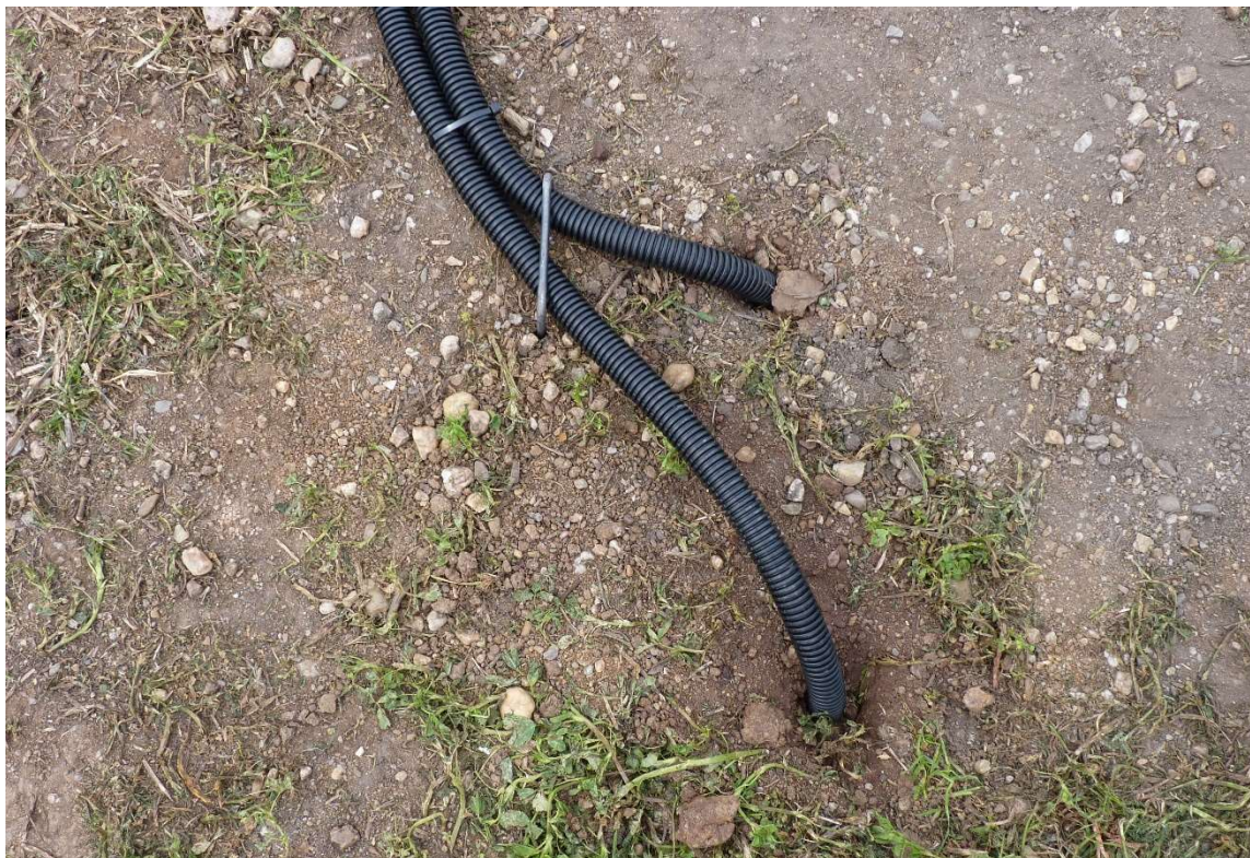
Die Stromkabel werden zusätzlich mit Schutzrohren gegen mechanische Beanspruchung und Tiere (Vögel, Nager) geschützt
