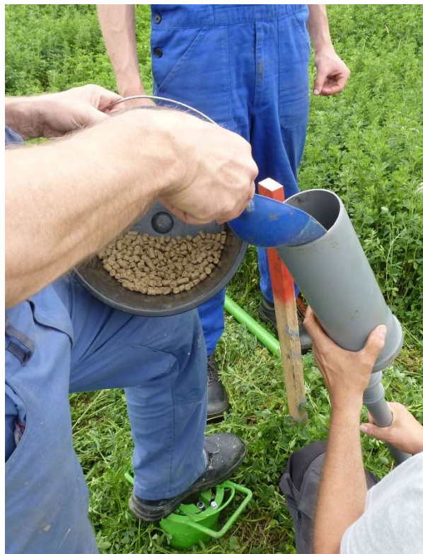
Restliches Bohrloch wird mit selbstquellenden Tonpellets verfüllt
