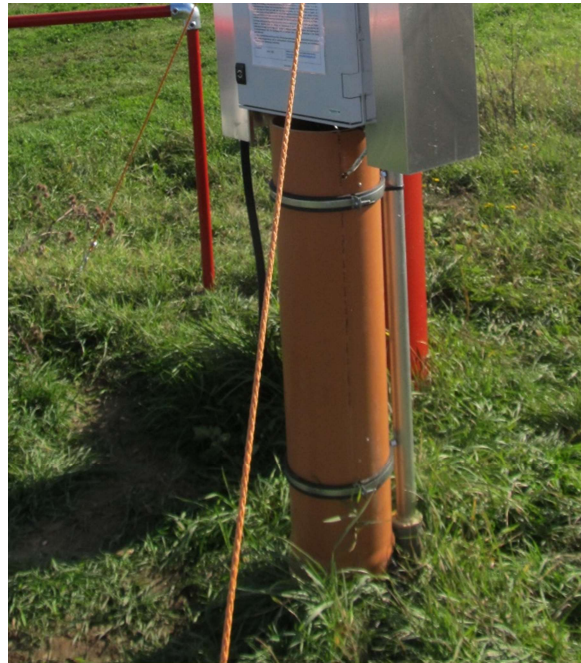
Schutzrohr für offenliegende Kabel; installiert am 15.10.2019
