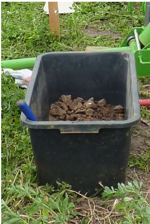
das Bohrgut wurde vorgesiebt und zum Bedecken der Sonde im Bohrloch genutzt
