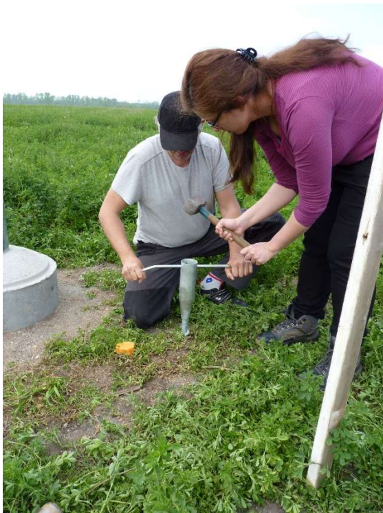
Einschlagen der Bodenhülse für den Mast an dem die Messeinheit und das Solarmodul befestigt sind
