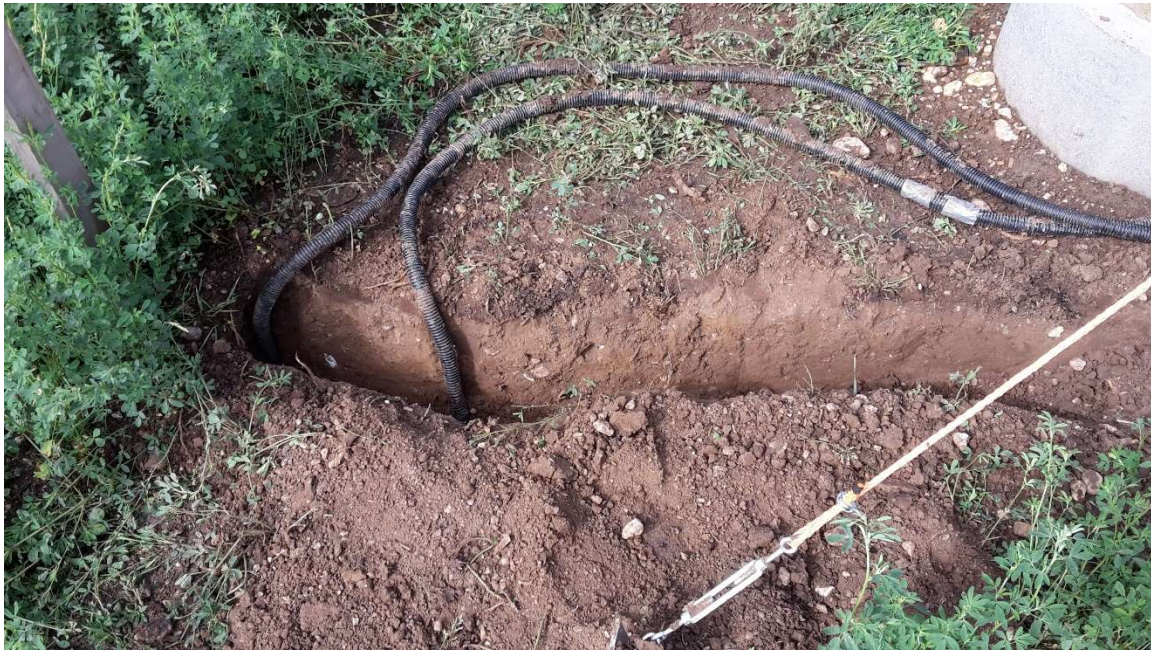
Am 20.06.2019 wurden die außerhalb des Anfahrschutzes oberirdisch verlaufenden Kabel etwa 20-30 cm vergraben
