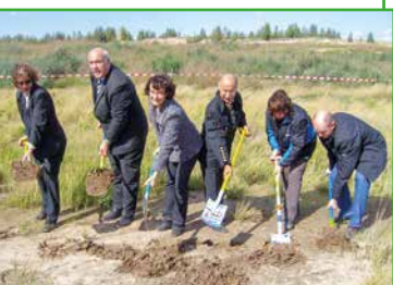
Erster Spatenstich für VINETA
