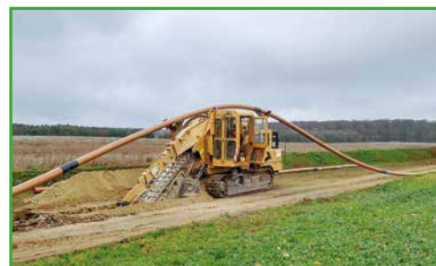
Bau der Laugentransportleitung
