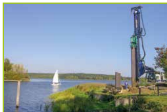
Sanierungsarbeiten am Knappensee
