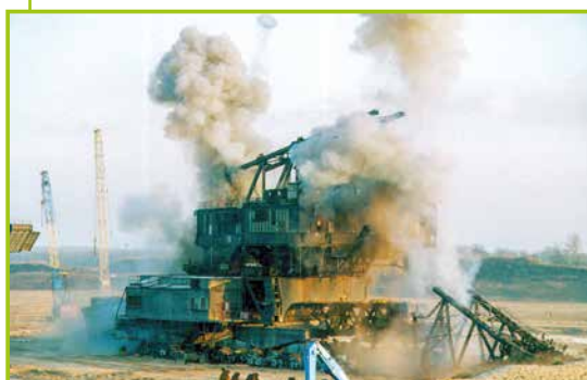
Sprengung der Abraumförderbrücke 18
