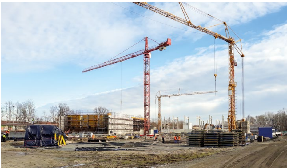
Hochbetrieb auf der Baustelle der Wasserbehandlungsanlage Plessa
