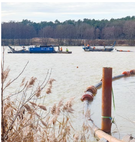
Saug- und Spültechnik der Firma TWB im Einsatz
