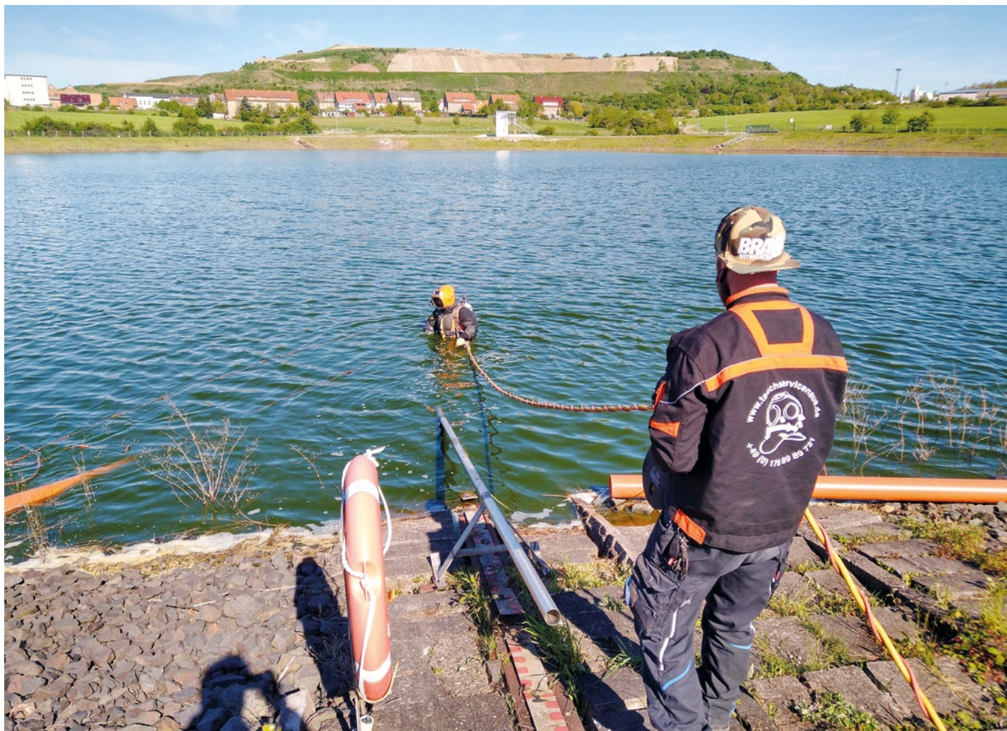
Begleitende Instandhaltungsarbeiten am LMBV-Laugenstapelbecken Menteroda durch einen Industrietaucher im Jahr 2020
