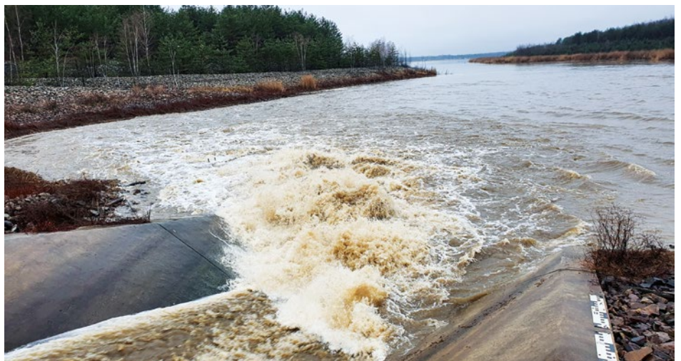
Einlauf in den Speicher Bärwalde mit etwa sechs Kubikmetern pro Sekunde Anfang Februar
