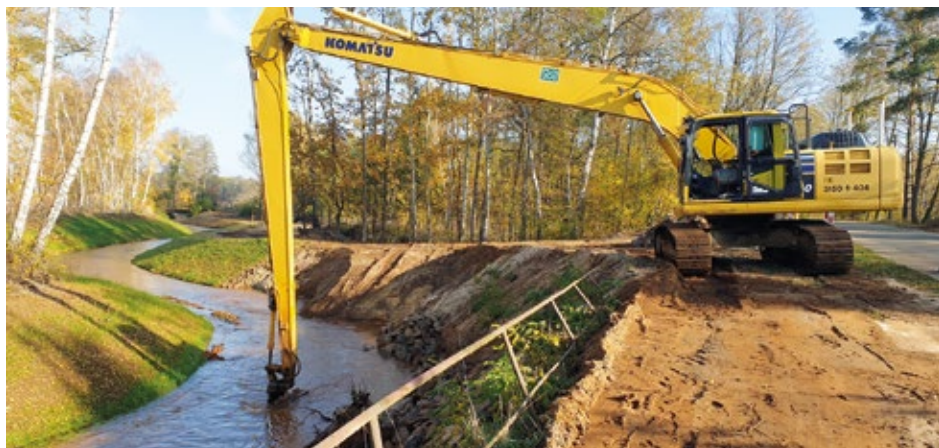
Befreiung der Gewässersohle der Kleinen Spree von sedimentiertem Eisenhydroxidschlamm
