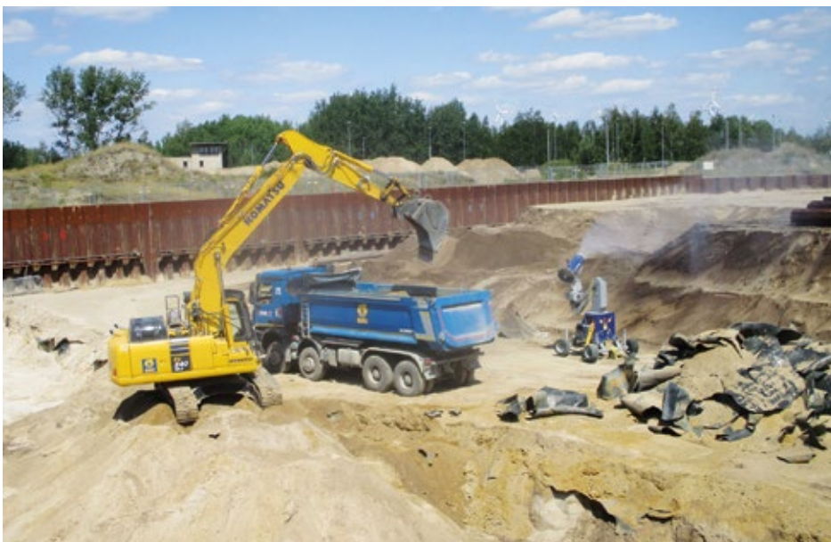
Voraushub im Bereich der Vorlagetanks (2. Bauabschnitt)
