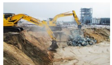
Unterflurabbruch im kontaminierten Bereich
