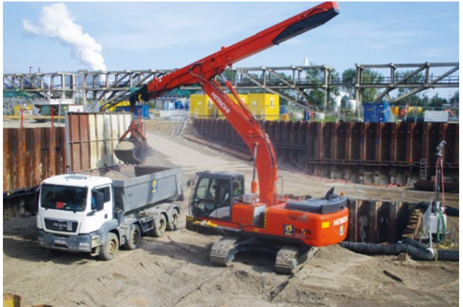
Tiefenaushub im Bereich Extraktion
