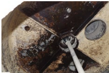
Behälter vor der Instandsetzung
