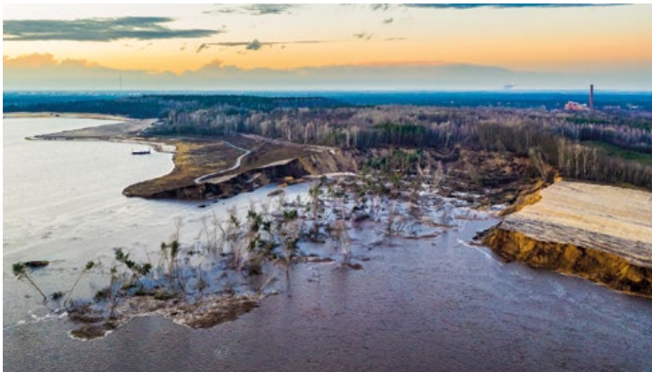
Auswirkungen des Setzungsfließens vom 11. März 2021 an der Nordostböschung des Knappensees
