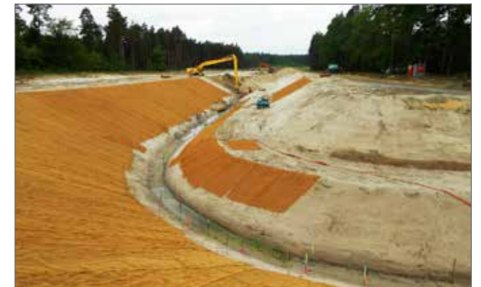
Grabenprofilierung mit erstem Grundwasserzuström
