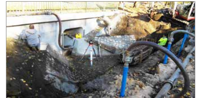
Erneuerung des Durchlasses an der Calauer Straße
