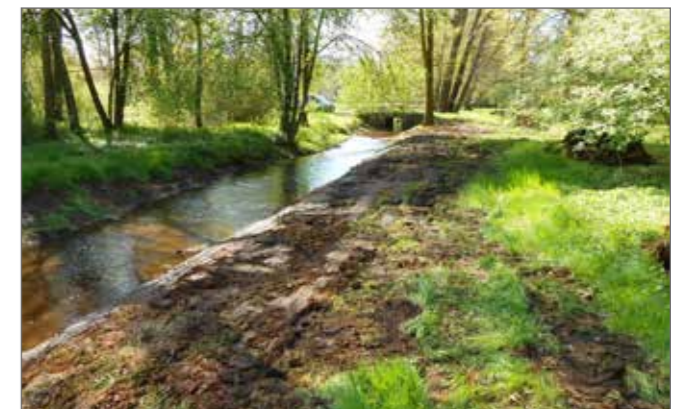
Sanierung des Grabens im Schlosspark Altdöbern
