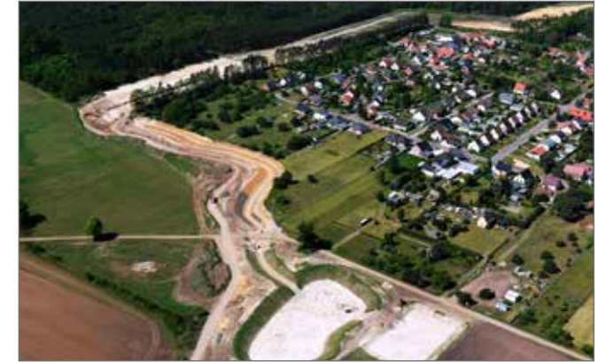
Der Neue Südgraben inkl. der Wasserfläche und EHS-Lagerung in der Bauphase.
