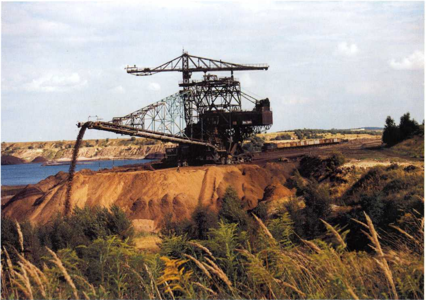
Böschungsanstützung im Rahmen der Maßnahmen zur Sanierung. (Foto: R. Bär)
