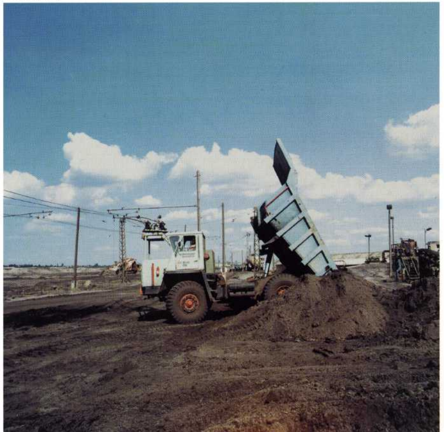
Abkippen von Schluff am Kippgraben aus einem elektrogetriebenen Belas-Kipper. (Foto: R. Bär)
