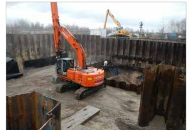
Bodenaushub mit Hilfe einer Spundwandkonstruktion und Teleskopbagger
