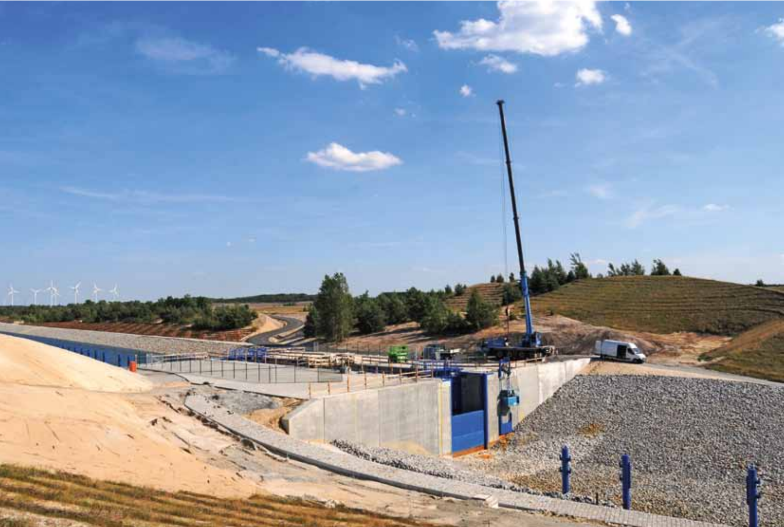
Bau des Überleiters 1, 2014
