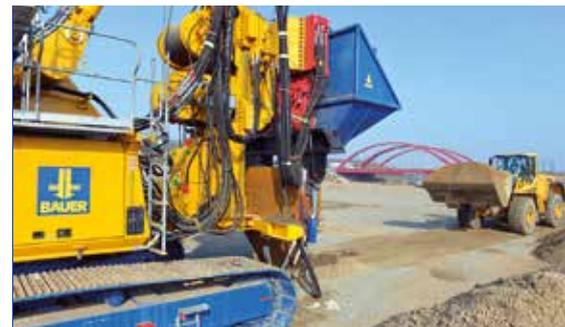
Materialzugabe zur Herstellung eines Kiesbohrpfahls
