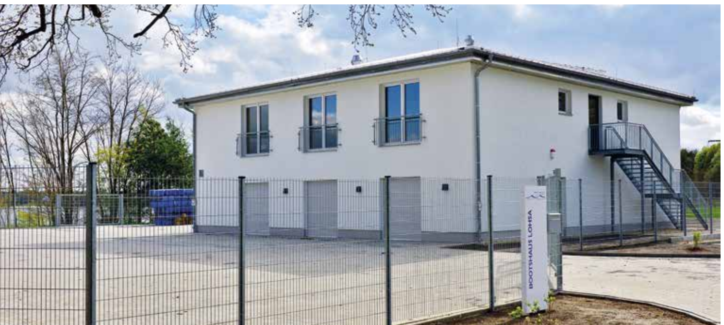
Neues Vereinsgebäude mit Bootshaus am Dreiweiberner See, 2017
