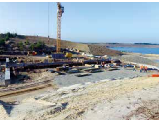
Bau der zukünftigen Schleuse im Überleiter 1, 2014
