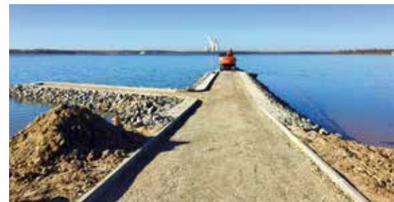
Einbau der Randbefestigungen, 2017
