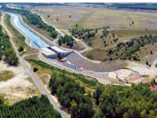
Trasse des Überleiters 1 mit Schleusenbauwerk, 2016
