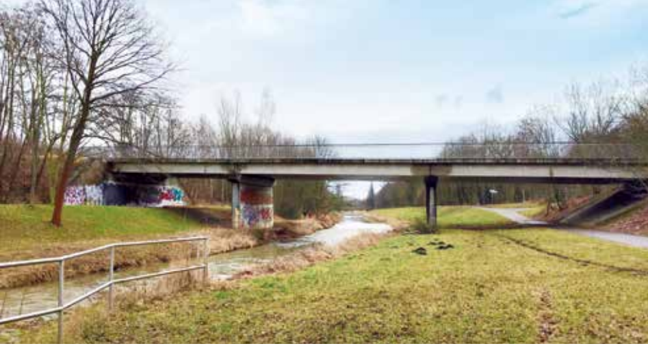
Brückenbauwerk über die Pleiße im zukünftigen Baufeld, 2017
