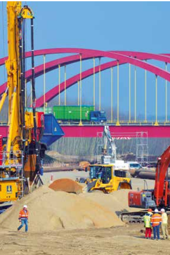
Verdichtungsmaßnahmen im Bereich der Trasse der entstehenden Gewässerverbindung, 2015
