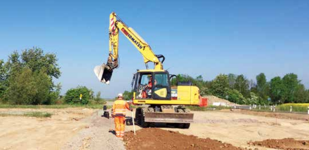
Einbau von Rigolen zur Flächenentwässerung des Parkplatzes am Störmthaler See, 2016
