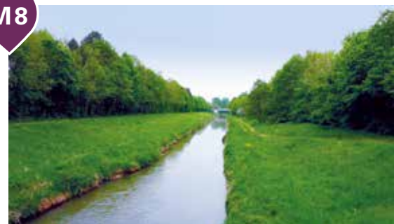
Pleiße vor dem Ausbau, 2017
