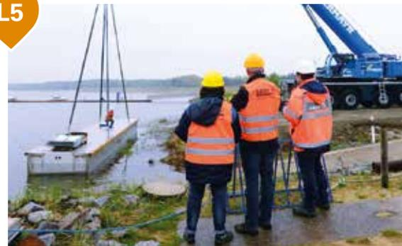
Einsetzen der Pontons für den Schwimmsteg
