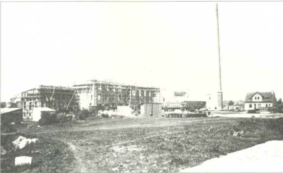
BAUARBEITEN AM PRESSENHAUS UND DER ZENTRALE 1909
