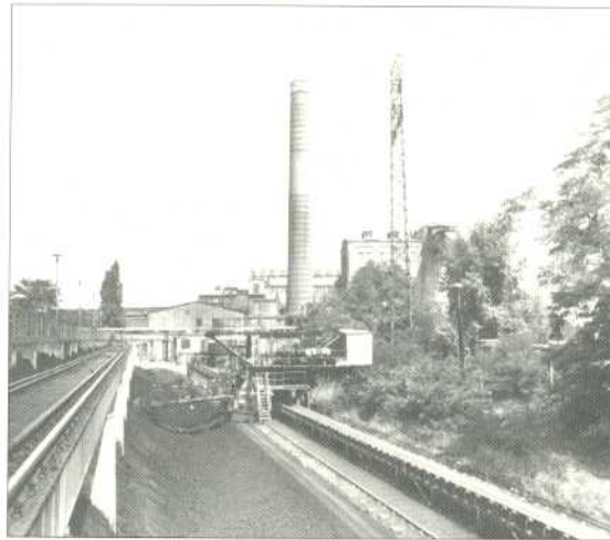
GRABENBUNKER DER BRIKETTFABRIK NACH DEM UMBAU 1969
