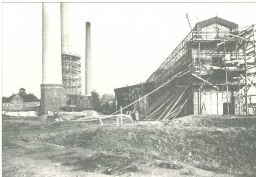
ERWEITERUNG DES KESSELHAUSES I 1916
