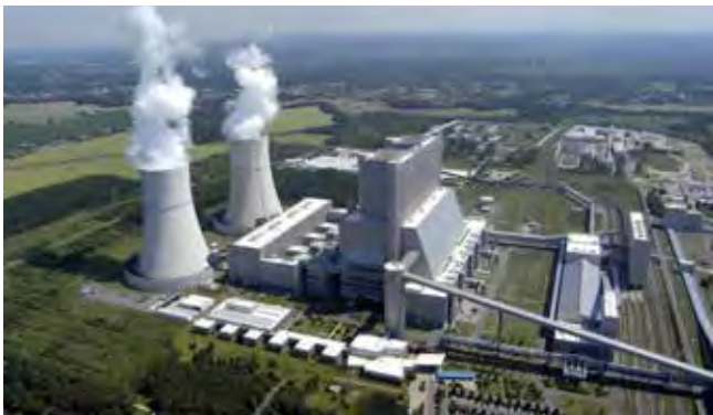
Kraftwerk Schwarze Pumpe
