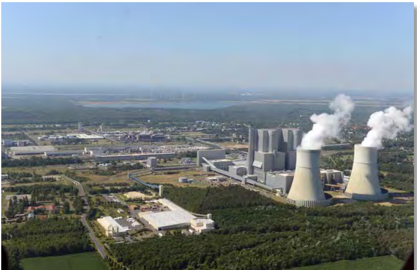
Industriepark Schwarze Pumpe mit dem Spreetaler See im Hintergrund
