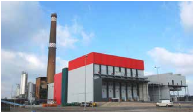
Neubau des Ersatzbrennstoffkraftwerkes
