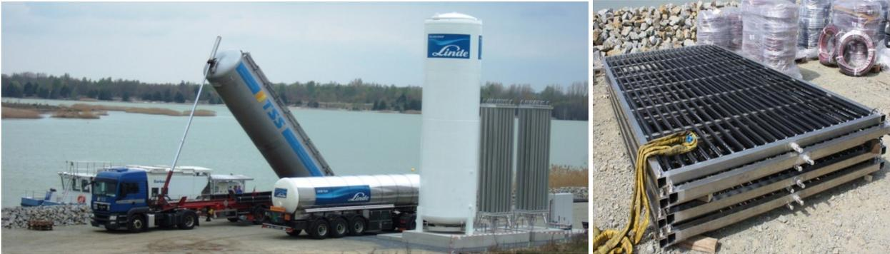
**Abb. 17:** Tank während der Befüllung mit verflüssigtem CO<sub>2</sub> sowie zugehörige Verdampferanlage, Anlegestelle mit Gewässerbehandlungsschiff hinter dem LKW während der Beladung mit Kalkhydrat (links) und Begasungsrahmen mit Mikroporen vor der Installation am Seegrund (rechts) (Quelle: LMBV)
