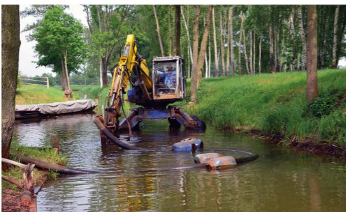
Mit einem Schreitbagger wird der Ragower Kahnfährrafen von eisenhaltigen Sedimenten beräumt, 2018.
