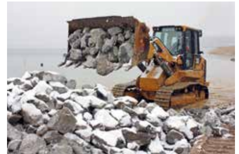
Steinschüttungen als Wellenbrecher.
