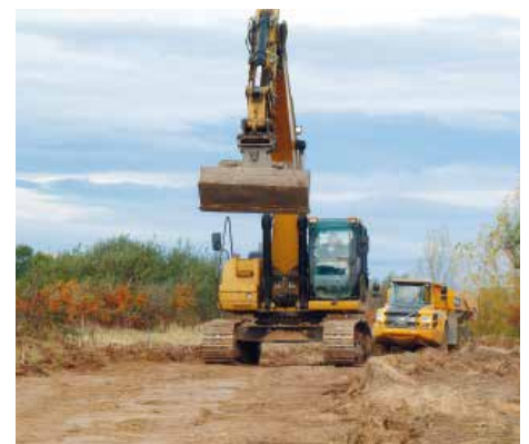
Wirtschaftswegebau zwischen der Ortslage Lissa und dem Grabschützer See.
