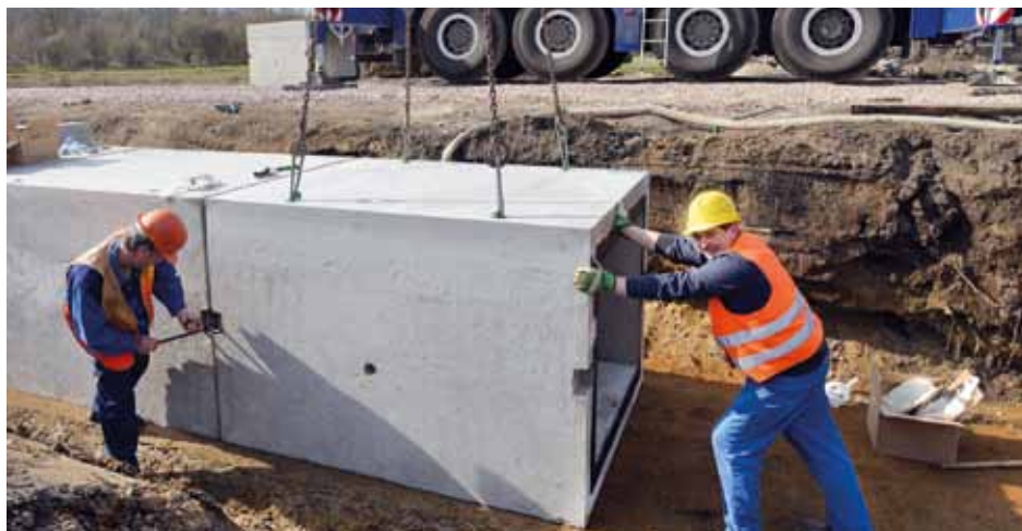
Mitarbeiter der TUG GmbH Oranienbaum beim Transport eines Teilstücks des Rahmendurchlasses.
