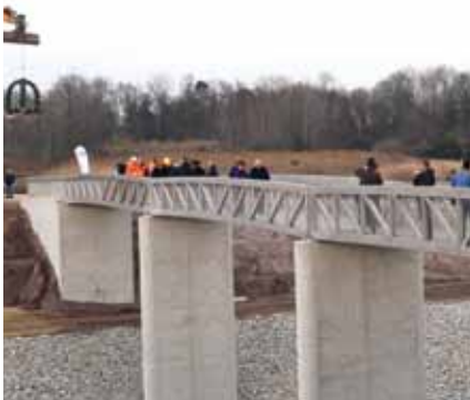
Richtfest für neue Radwegebrücke.
