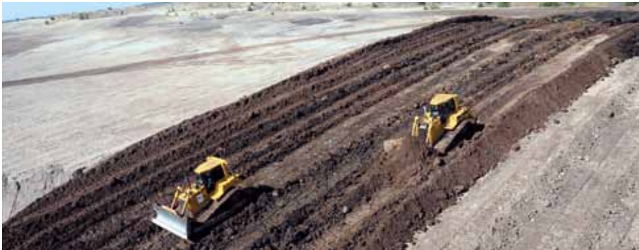
Vor den Sprengungsarbeiten an der Schwarzen Keute liefen Erdarbeiten.
