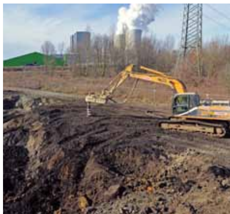
Konditionierung des teerhaltigen Erdreiches im Klärteich BC des Auflandebeckens Gaulis.
