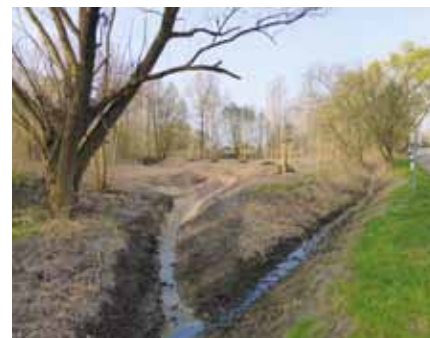
Entlang des geöffneten Grabens wurden unter anderem Erlen und Weiden gepflanzt.
