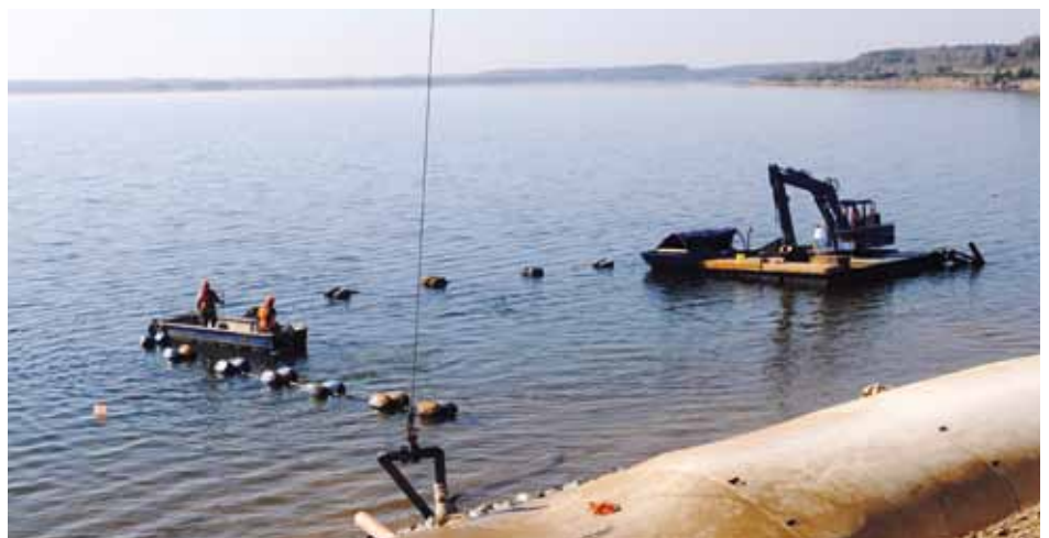
Am Ufer des Sedlitzer Sees nahe der Ortslage Lieske werden zur Stabilisierung „Geotubes“ eingebaut.
