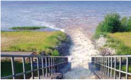
Wasserauslass von der Schwarzen Elster in das Restloch Bluno.
