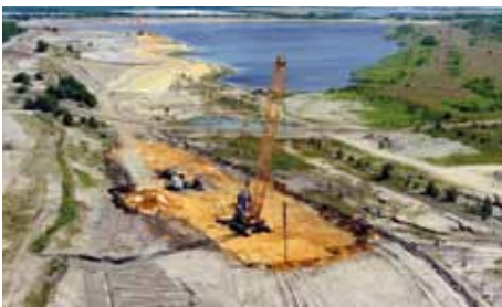
Rütteldruckverdichtung im Bereich der Tagebaufelder Lauchhammer zur Sicherung von Kippenflächen.
