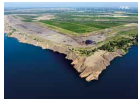
Rütteldruckverdichtungsgeräte verdichten die Böschungen am Klinger See.
