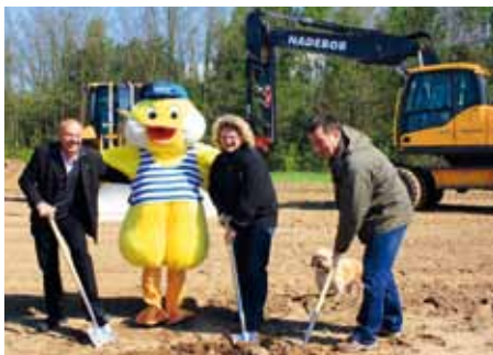
1. Spatenstich für den Zeltplatz am Bärwalder See.
