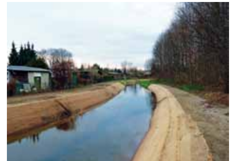
So wie hier am 3. Bauabschnitt soll auch der nächste Gewässerabschnitt des Lobers ausgebaut werden.
