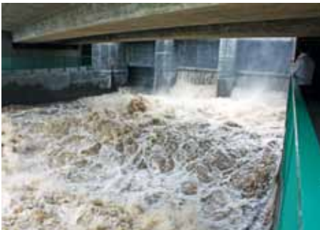
Die Öffnung der Hochwasserentlastung bei Zitzschen entlastet die Weiße Elster vor Leipzig.
