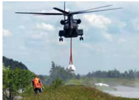
Bundeswehr schließt mit über 700 Big Bags das „Leck“ zwischen Seelhausener See und Goitzsche.
