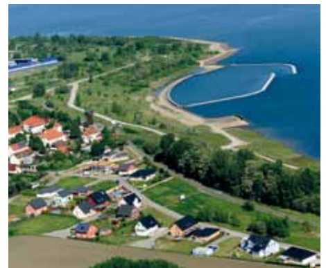
In diesem Böschungsbereich am Geiseltalsee bei Braunsbedra haben Erdbaumaßnahmen begonnen.
