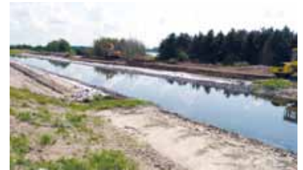
Beim Einbau der Dichtungsfolie in den Lober-Leine-Kanal.
