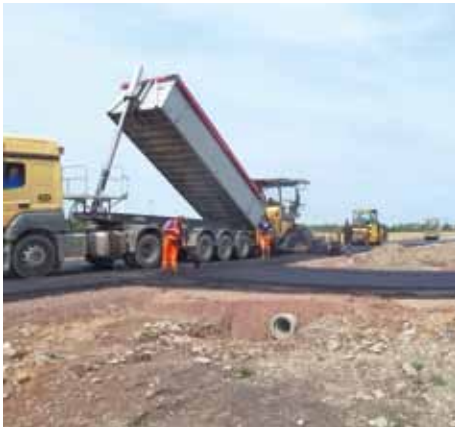
Der Bau der Straße zum Werbeliner See im Süden Delitzsch schreitet planmäßig voran.
