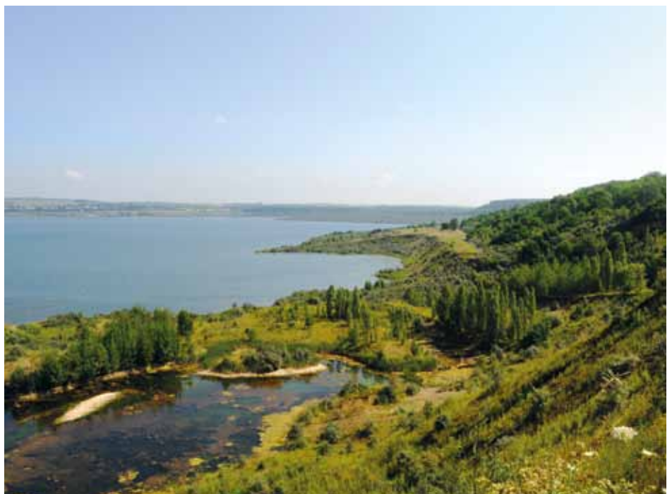
Blick auf den östlichen Bereich des Rutschungskessels.
