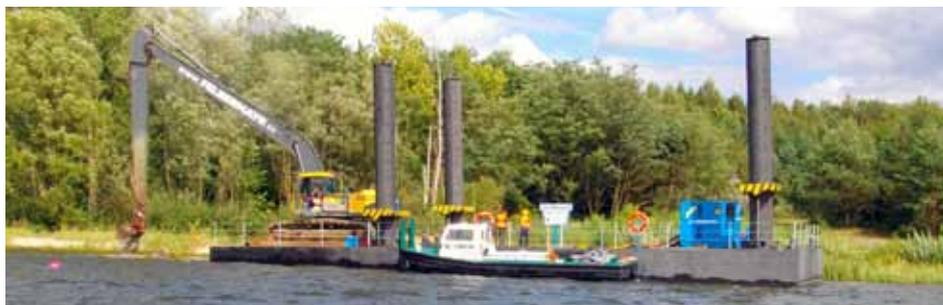
*Mit dem Einsatz des schwimmenden Langarm-Baggers beginnen die seeseitigen Sanierungsarbeiten am Knappensee.*
