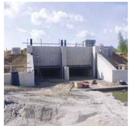
**Zwenkau.** Die Bauarbeiten am Zwenkauer See für den Betriebsauslass zur Weißen Elster bei Hartmannsdorf liegen im Zeitplan. Der Stahlbetonbau für die knapp 100 Meter langen zweizügigen Rahmendurchlässe ist komplett abgeschlossen, die Erdarbeiten sind sehr weit fortgeschritten. Die Montage der Elektro-, Mess-, Steuer- und Regelungstechnik (EMSR) und Leittechnik hat begonnen.
