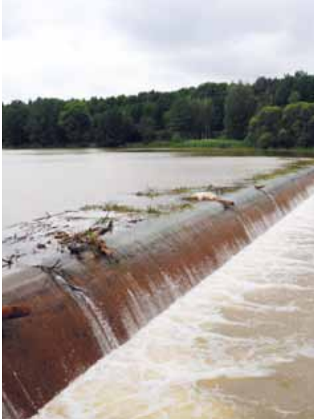
Die Vorsperre Bühlow in der Spree kurz vor der Talsperre Spremberg.
