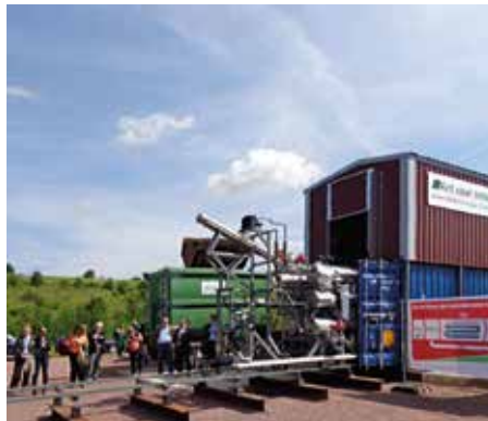
Inbetriebnahme der Demonstrationsanlage.
