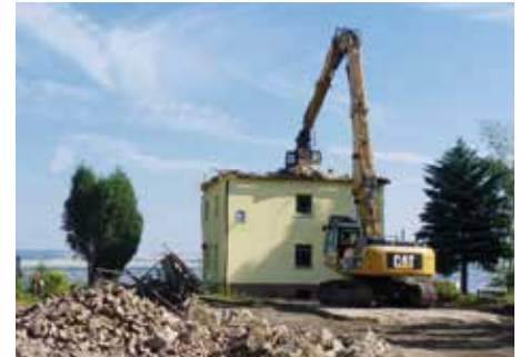
Die letzte Doppelhaushälfte in der Siedlung am Ring wurde im Juli abgerissen.
