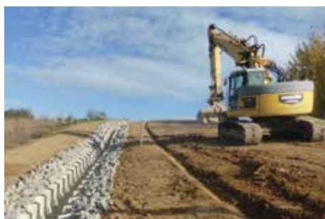
Das Oberflächenwasser wird künftig teilweise über Kaskaden in den „Silbergraben“ abgeleitet.
