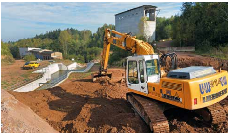
Bauarbeiten an der Sickerwasserableitung im erzgebirgischen Bielatal.
