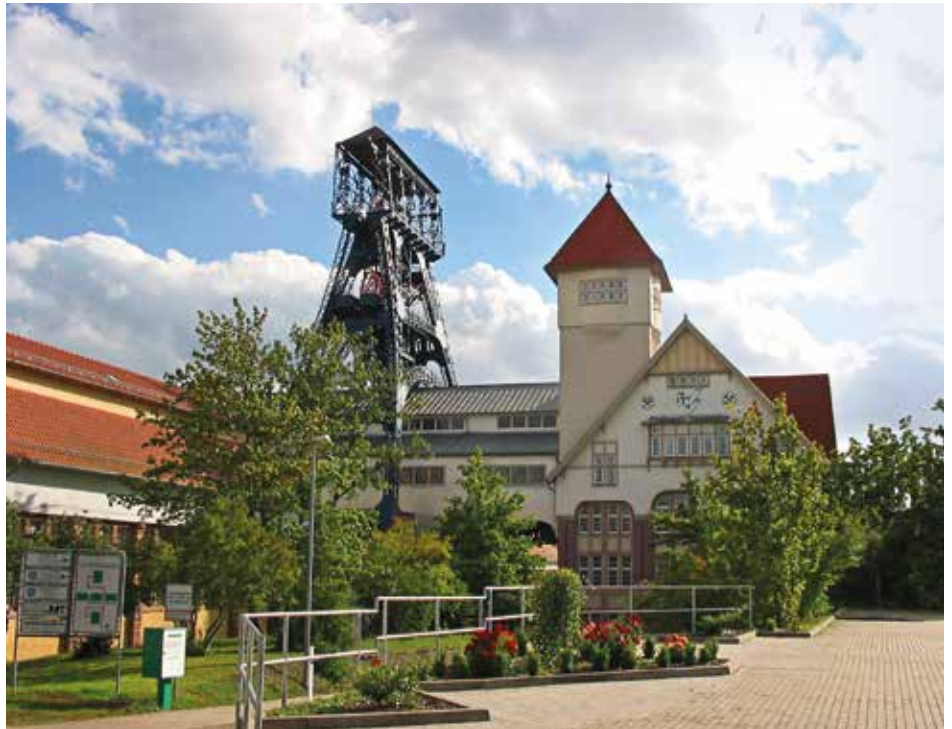
Zentrale des LMBV-Bereiches Kali-Spat-Erz im thüringischen Sondershausen.
