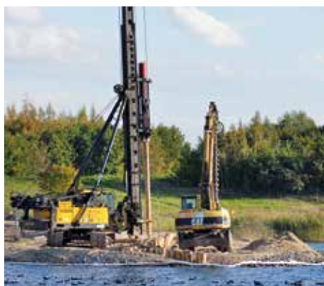
Buhnenbau am Brodauer Ableiter.
