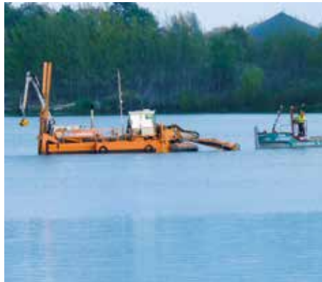
Unterwasserholzung auf dem Seelhausener See.
