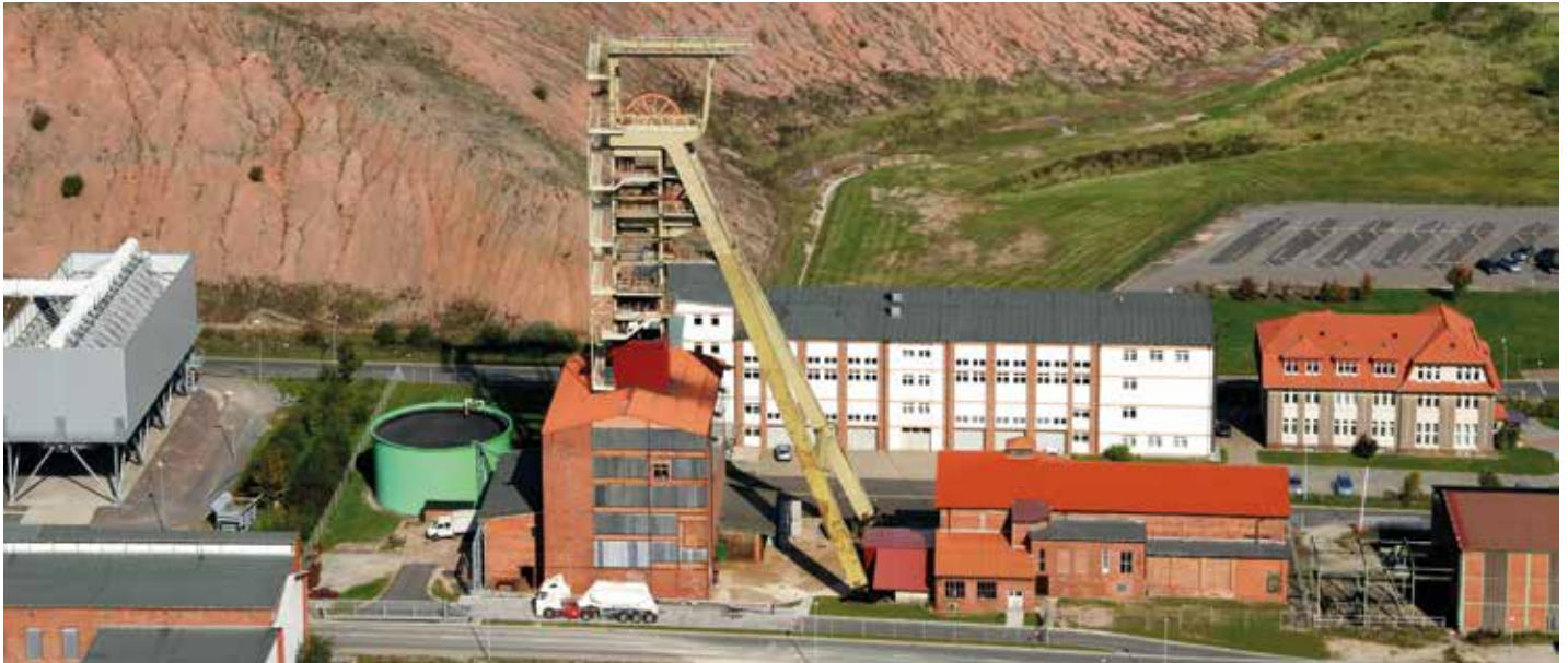
Betriebsanlage des Bergwerks Bischofferode des LMBV-Bereiches Kali-Spat-Erz.
