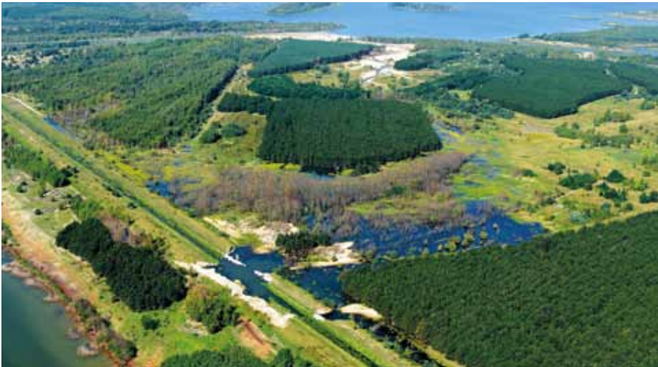
Schadensgebiet zwischen Seelhausener See (l.) und Großem Goitzschensee im September 2013: Im Bereich des Lober-Leine-Kanals sind stabilisierende „Big Packs“ sichtbar.
