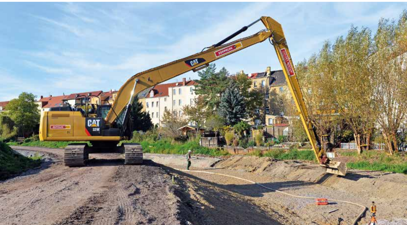
Bagger mit langer Grabenausrüstung bei der Böschungsprofilierung zum Loberausbau in der Innenstadt von Delitzsch (o.) Bau eines Horizontalfilterbrunnens zur Grundwasserabsenkung, Laugfeld in Senftenberg (u.l.) Rüttelstopfverdichtung am Ufer des Silbersees, 2012 (u.r.)
