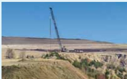
Herstellung eines „versteckten Damms“ zur Böschungstabilisierung mit Rütteldruckgeräten am Klinger See, 2006
