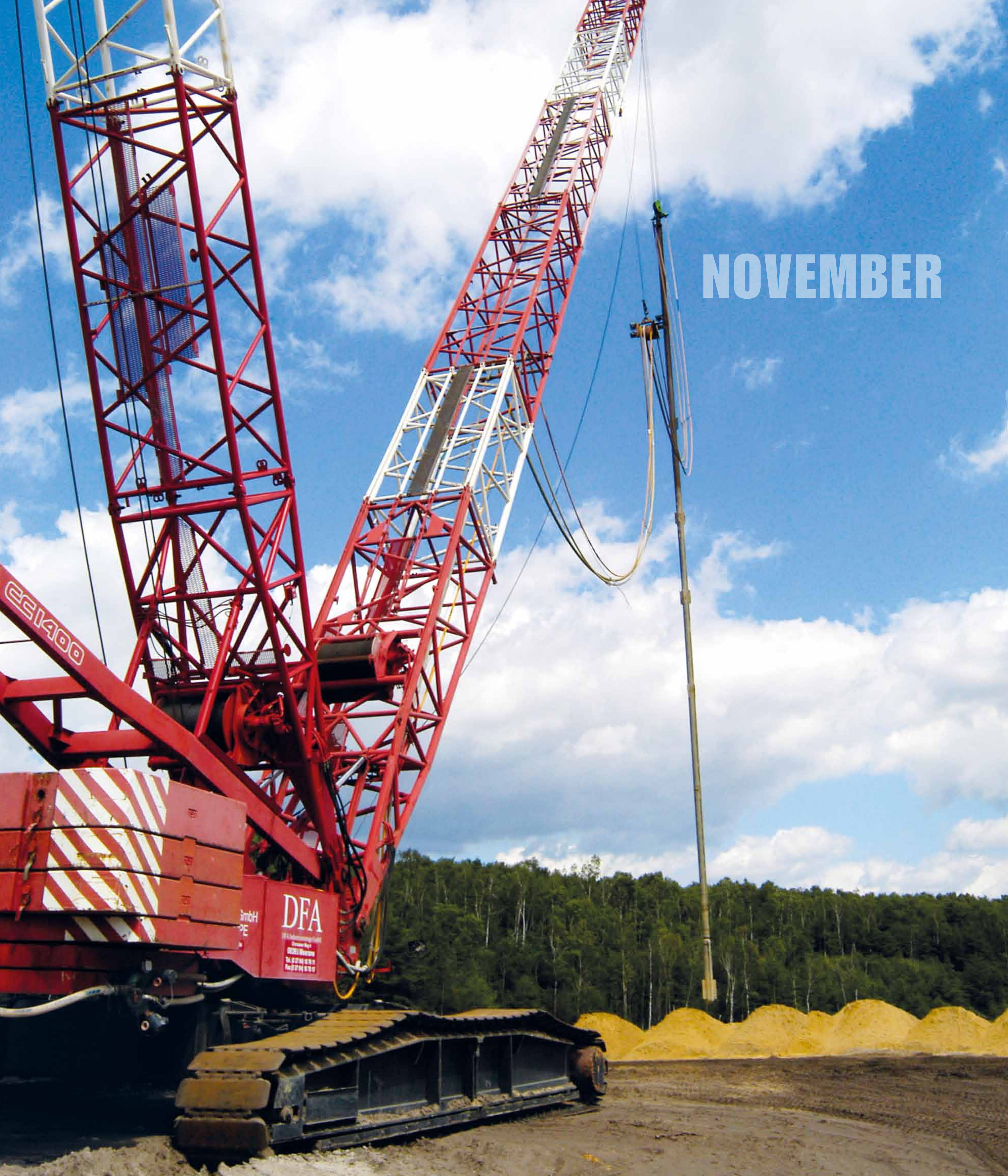
Raupenseilbagger als Trägergerät zur Rütteldruckverdichtung am Wildschweintech im Bereich der ehemaligen Deponie Hörlitz
