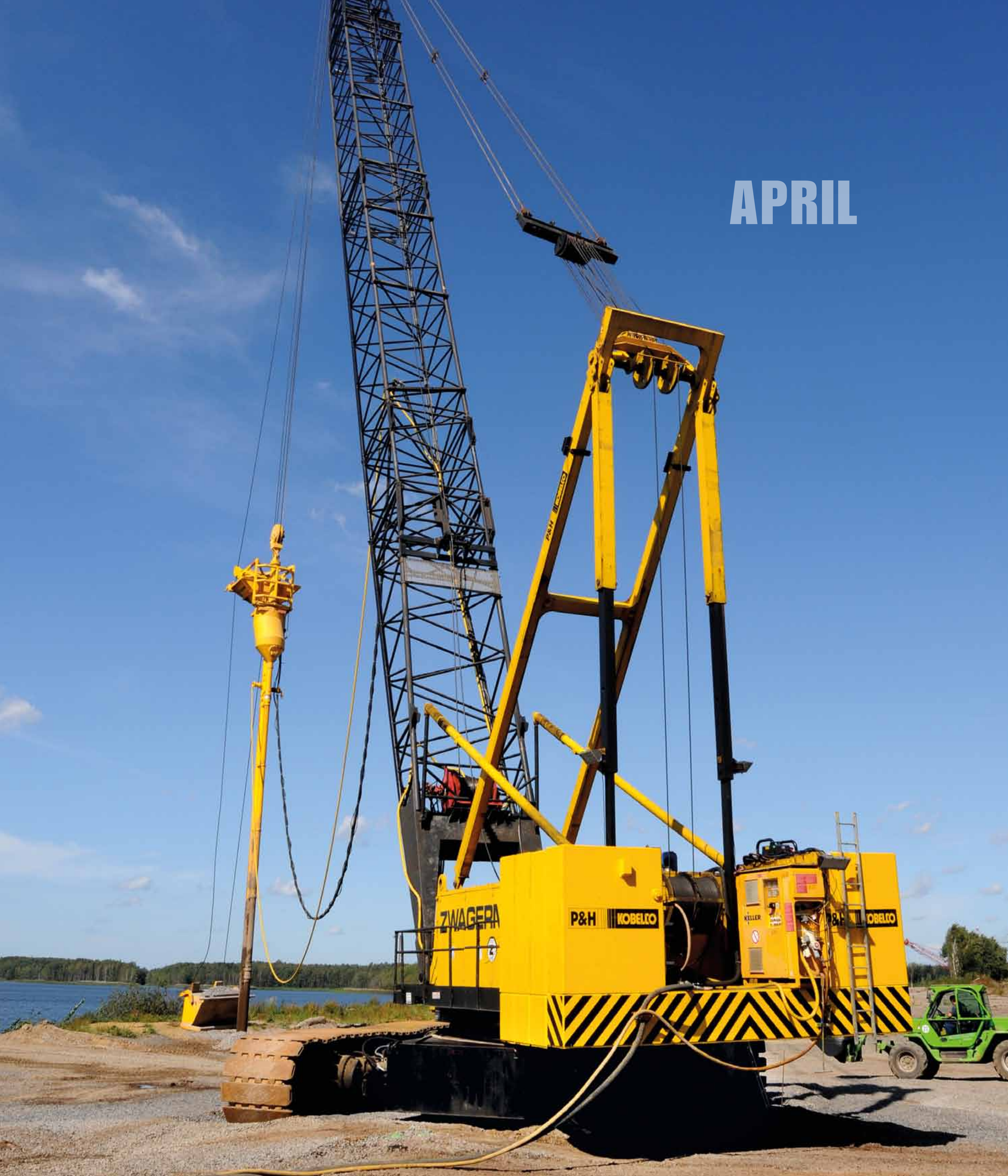
Raupengestützter Seilbagger bei der Rüttelstopfverdichtung zur Sicherung der Uferböschungen des Silbersees
