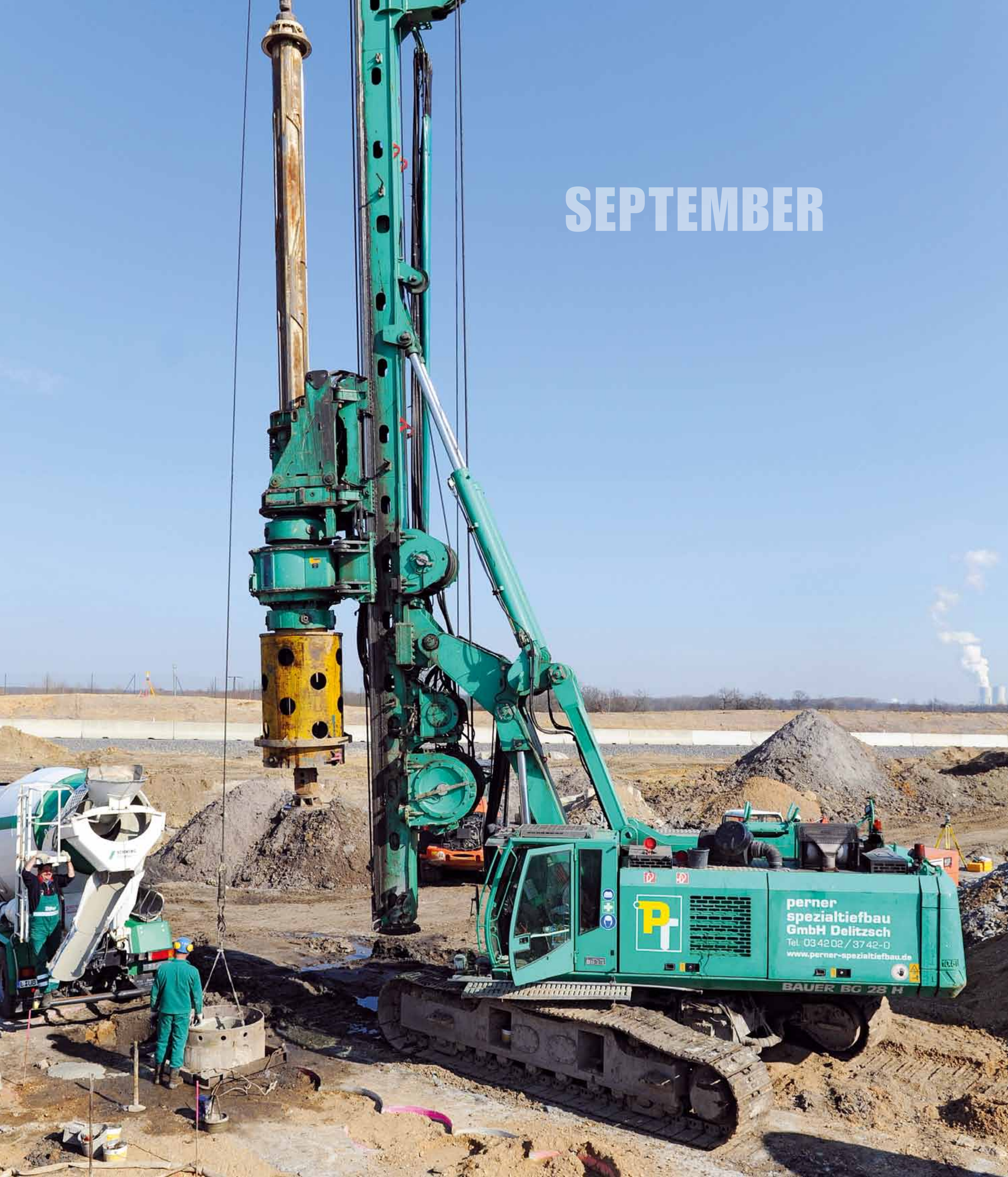
Großdrehbohrgerät zur Herstellung von Bohrpfahlwänden für den Brückenbau der B 186 am Zwenkauer See
