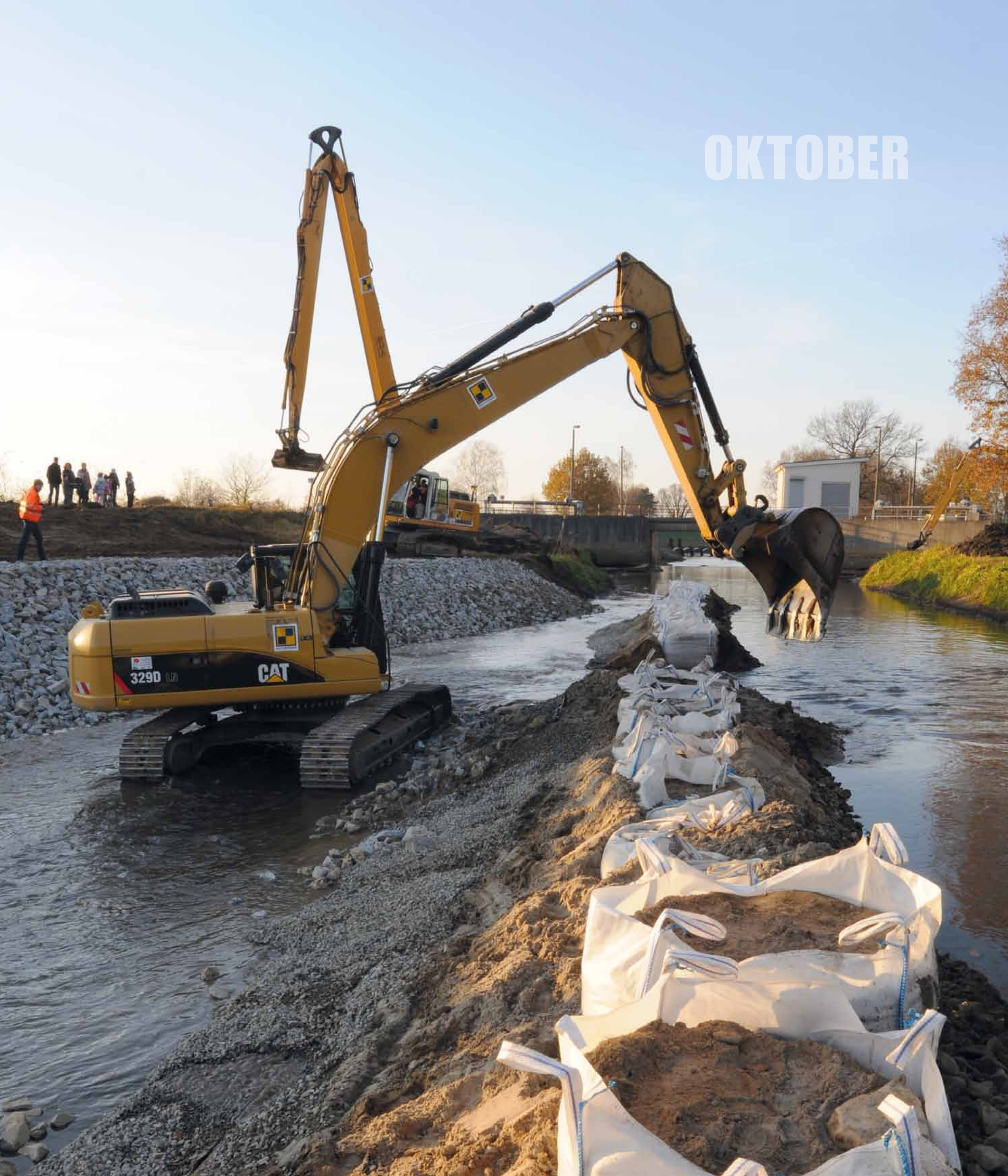
Hydraulik-Kettenbagger bei der Verlegung der Schwarzen Elster im Zuge des Baus des Überleiters 12
