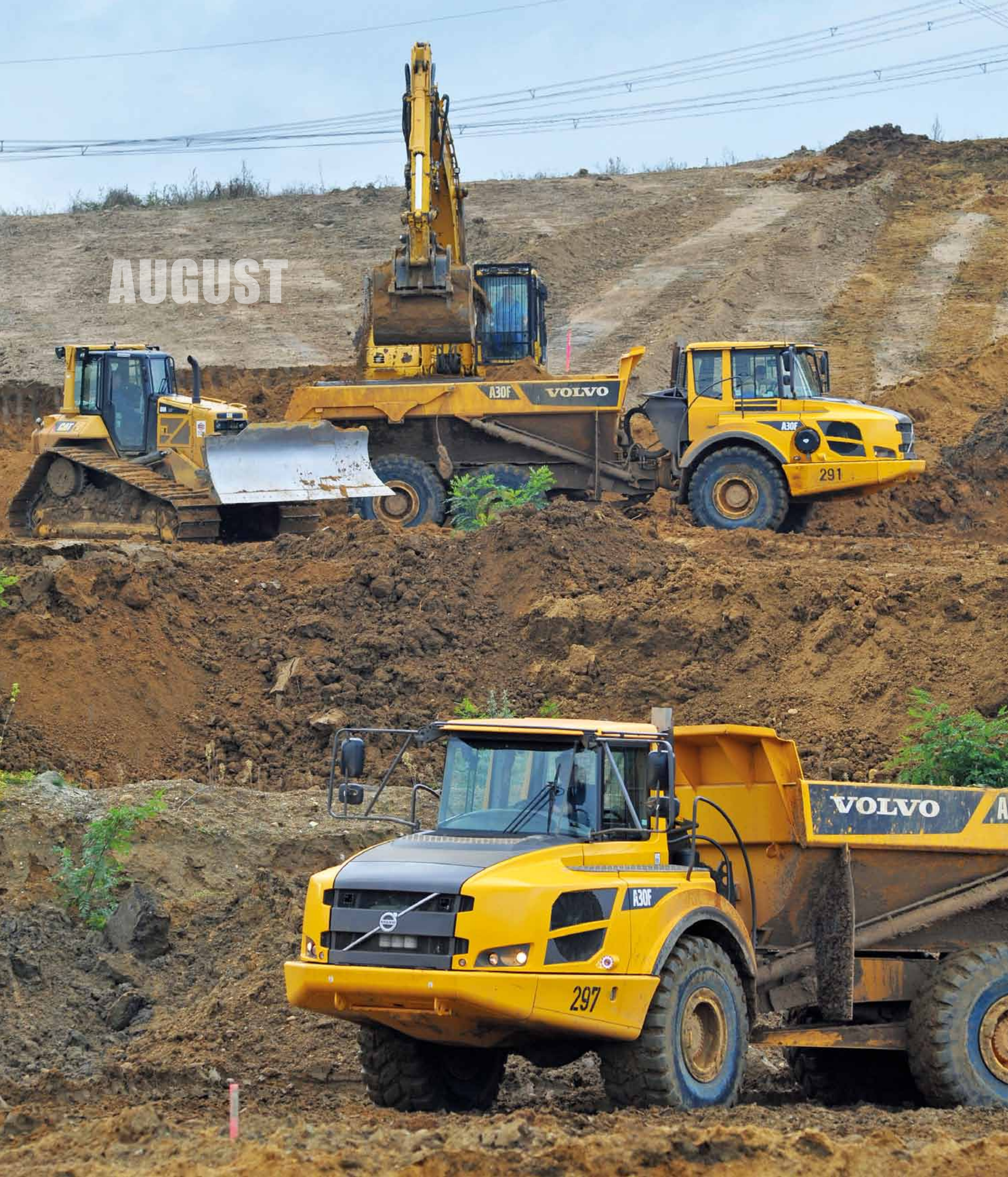
Mobile Erdbautechnik im Einsatz am Einschnitt des Harbker Mühlenbaches im Restloch Wulfersdorf
