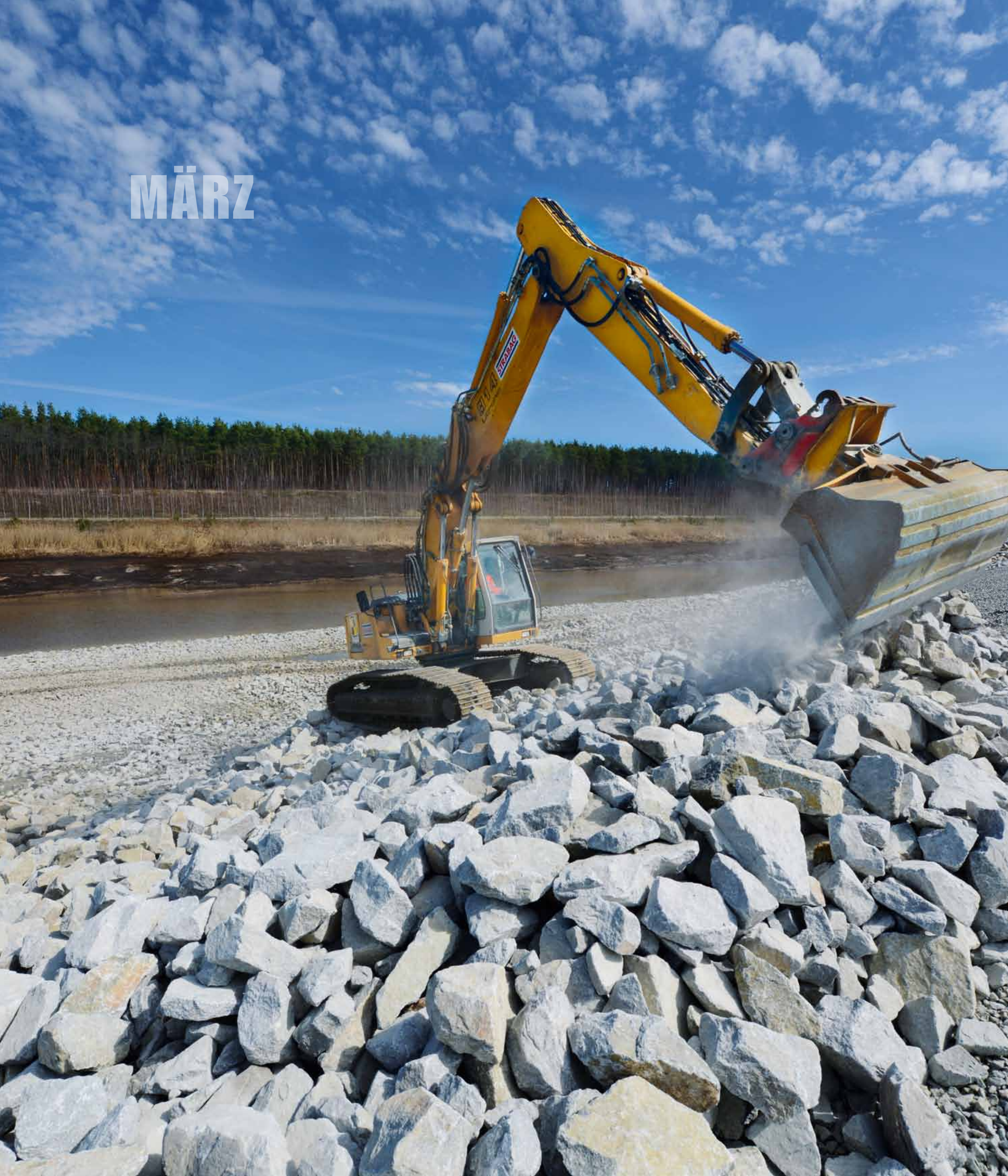
Langarmbagger bei Böschungsarbeiten am Überleiter 12 zwischen Geierswalder See und Senftenberger See
