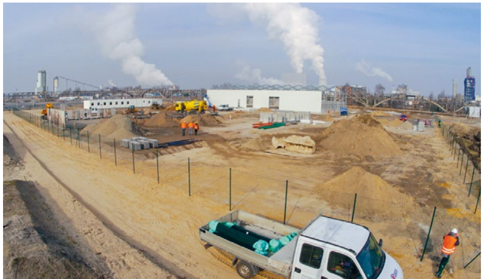
Errichtung einer Lagerhalle am künftigen VTRA-Standort Schwarze Pumpe
