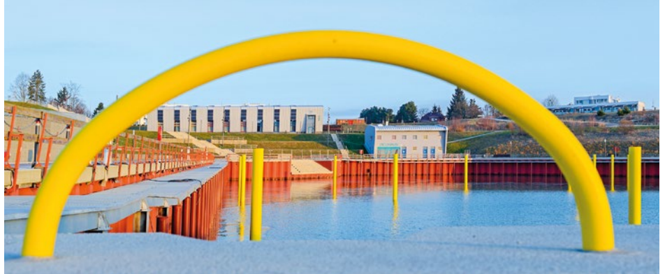
Neues Hafenbecken in Großräschen
