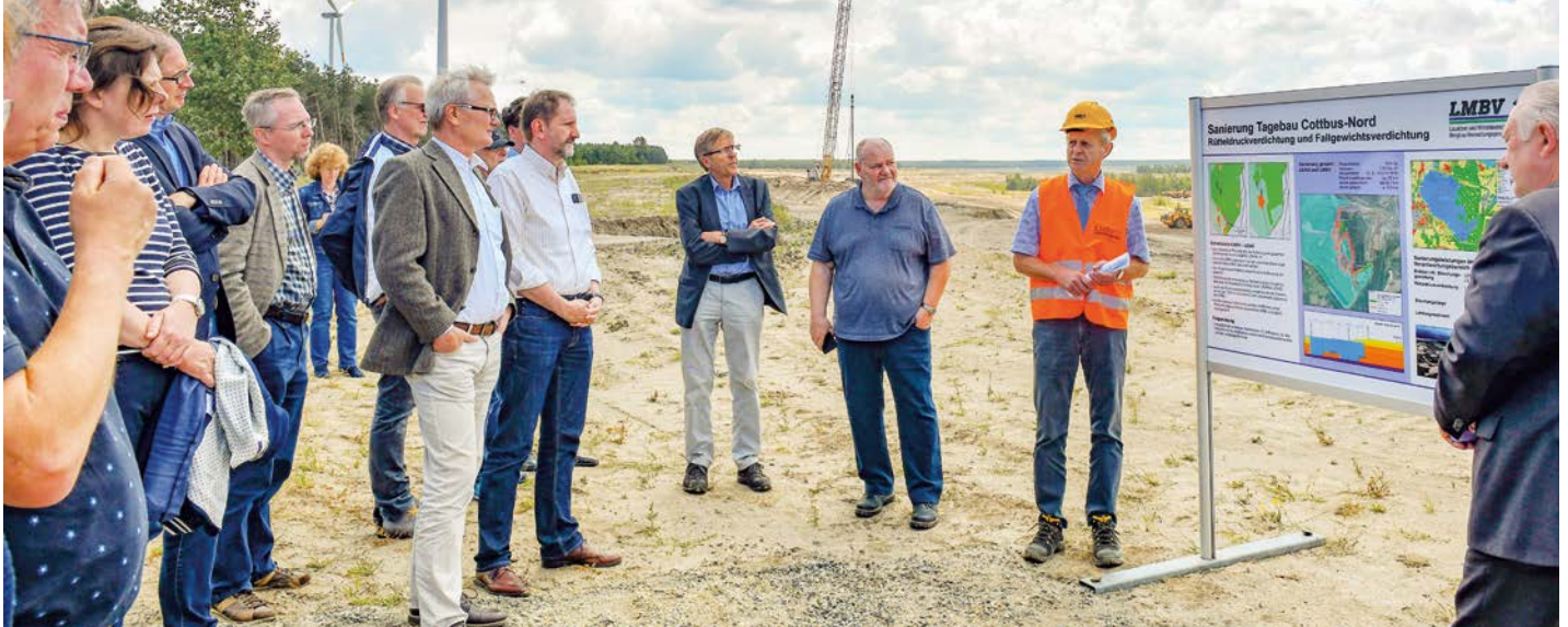
Interessanter Befahrungsauftrag an der Sanierungsbaustelle am künftigen Cottbuser Ostsee: LMBV-Bereichsleiter M. Kolba und Projektmanager D. Kutzschbach ordnen das Vorhaben ein.
