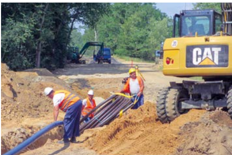
Verlegung der Medien unter der Fahrbahntrasse
