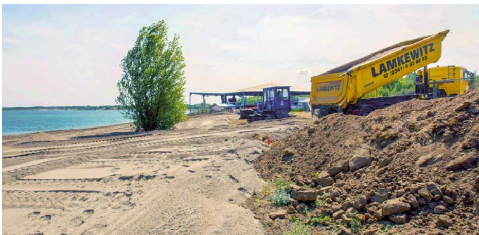
Rund 4.800 Tonnen Sand werden derzeit am neuen Seestrand Hayna am Schladitzer See aufgetragen.
