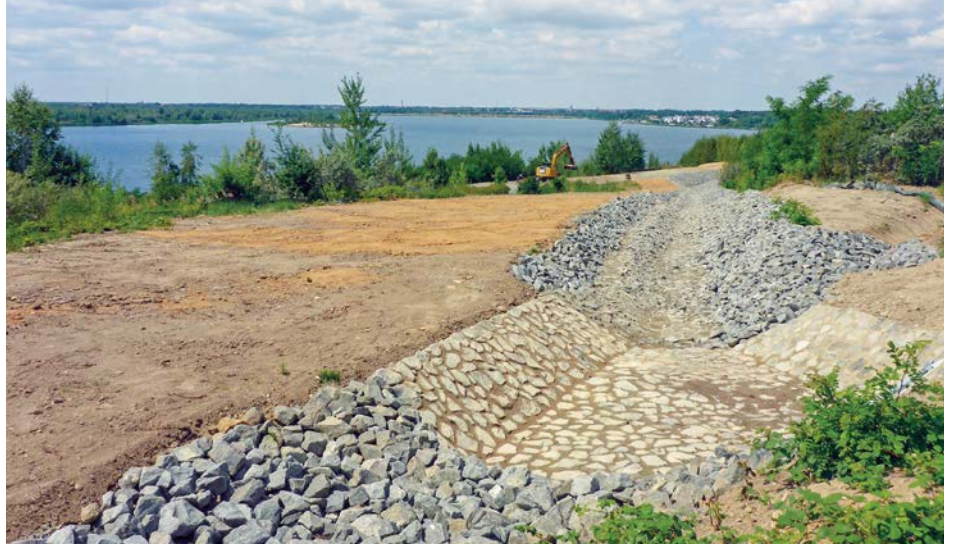
Der Auenhainer Graben und sein Einlauf in den Markkleeberger See sind fertiggestellt.
